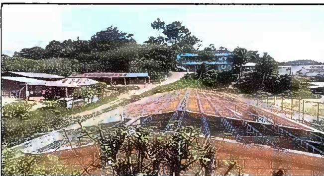
Foto 3: Módulo 1: Mantenimiento de estructura de metal
