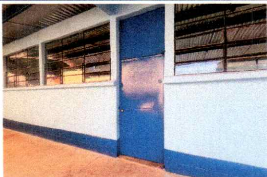
Foto 7: Se puede verificar la finalización del remozamiento en puertas de metal + chapa.
