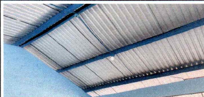
Foto 4: Se observa el remozamiento en estructura portante de metal, instalación de cubierta de lámina troquelada calibre 26 y aplicación de pintura en muros interiores de aula 2, finalizado.
