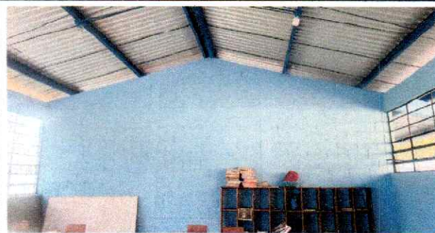
Foto 3: Se observa el remozamiento en estructura portante de metal, instalación de cubierta de lámina troquelada calibre 26 y aplicación de pintura en muros interiores de aula 1, finalizado.
