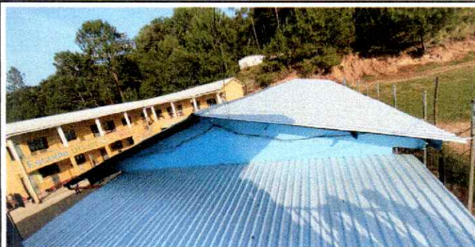
Foto 2: Puede verificarse la finalización de cambio de cubierta de lámina troqueada calibre 26 en módulo de aulas.
