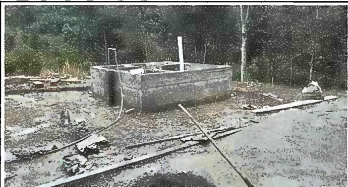
Foto 3: MODULO 2. Sustrucción de pila de concreto de tres lavaderos IN SITU
