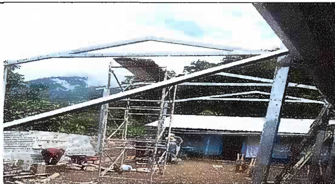
Patio: Foto 1, Sustitución de lámina por lamina troquelada aluzinc calibre 26.
