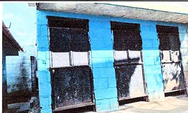
Foto 3: Mantenimiento, lijado y pintado de 2 puertas
