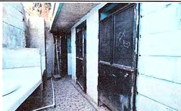
Foto 4: Sustitución de 4 puertas de 63cm.X 1.53 MTS.
