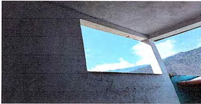
Foto1: Fabricación e instalación de ventana PVC de 1.90 mts. X 1.25 mts.
