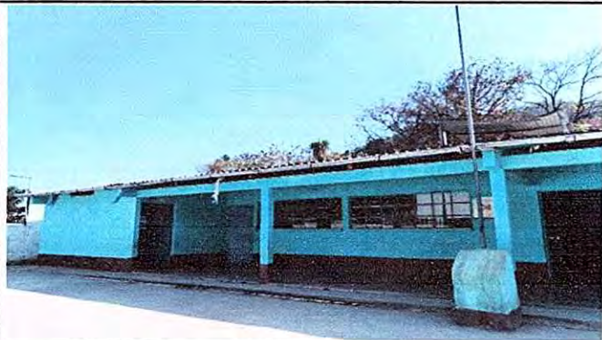
Foto1: Sustitución de canal de PVC m2
