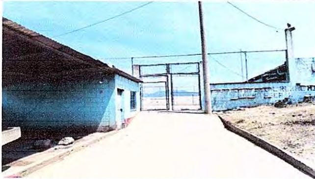
Foto1: Fabricación e instalación de portón de metal
