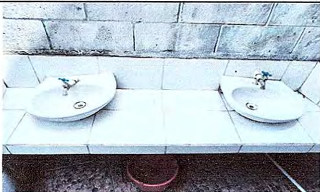
Foto1: sustitución de chorros
