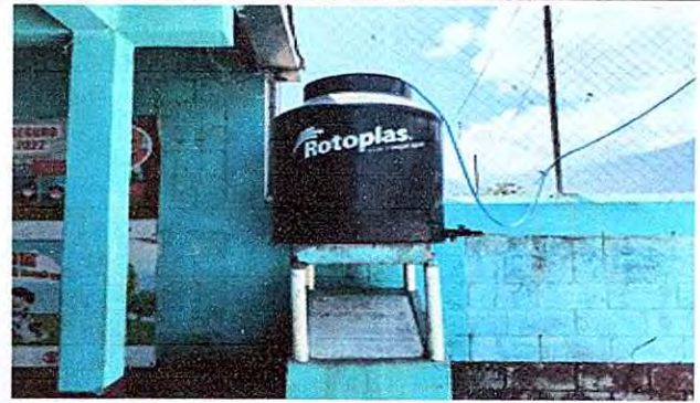
Foto 2: Reparación de bajada de agua
