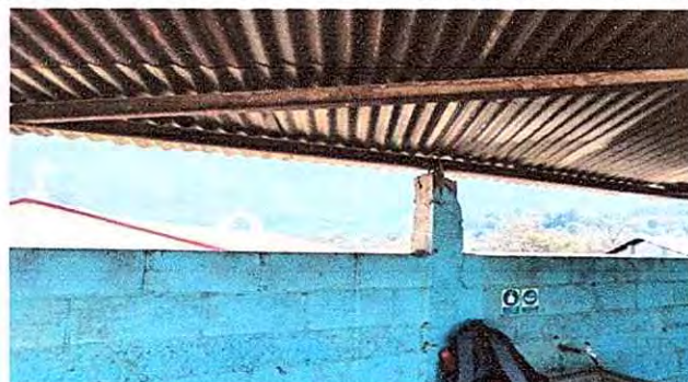
Foto 6: Lavantado de cocina
