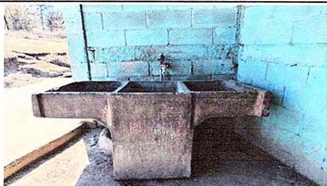
Foto 3: Sustitución de pila de cemento
