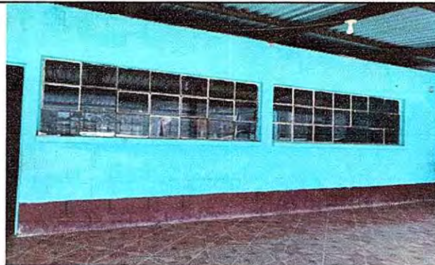
Foto 2: Fabricación e instalación de balcones en ventana
