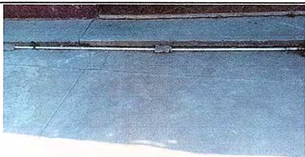
Foto 5: Sustitución de tubería de línea principal
