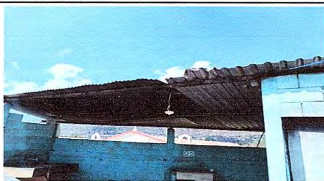
Foto 5: Sustitución de lámina troquelada alizinc calibre 26
