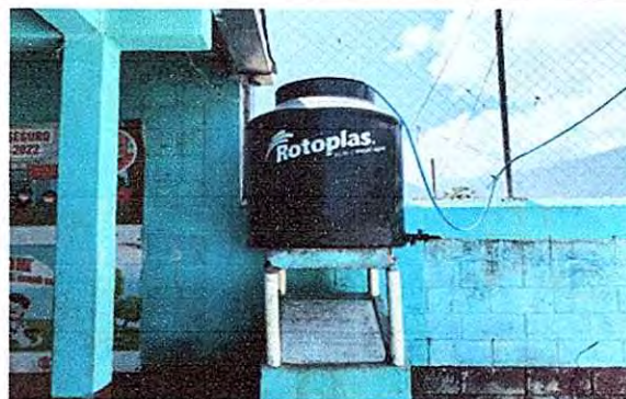
Foto 2: Sustitución de depósito de agua de 2,500 lts.
