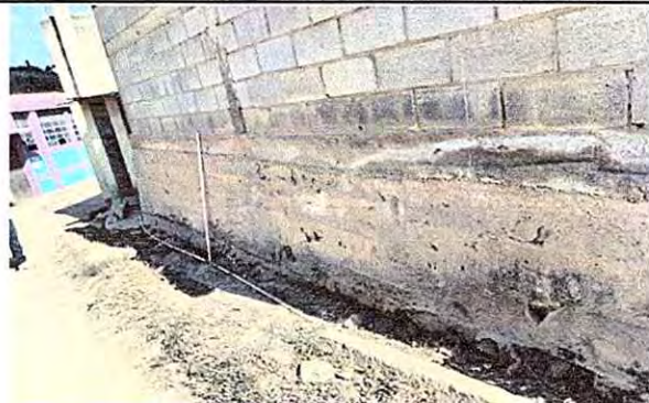
Foto 2: Reparación de cuneta de concreto
