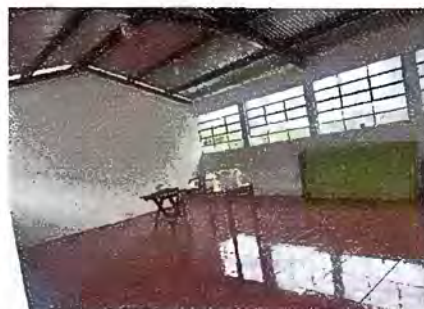
Modulo 1: Instalación de pisos en aulas
