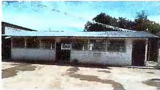
Modulo 1: Repello en paredes de aulas
