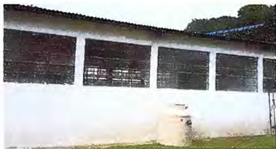
Modulo 1: Repello en paredes de aulas
