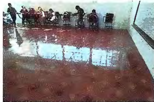
Modulo 1: Instalación de pisos en aulas
