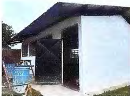
Modulo 1: Repello en paredes de aulas
