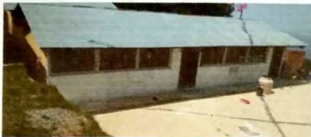
Modulo 1: Repello en paredes de aulas
