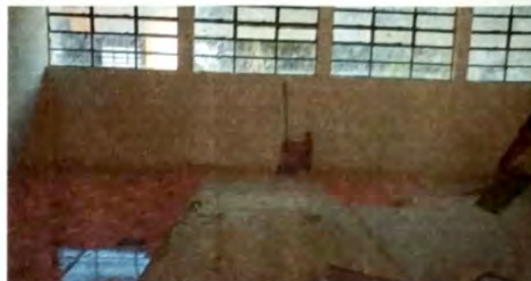
Modulo 1: Instalación de pisos en aulas
