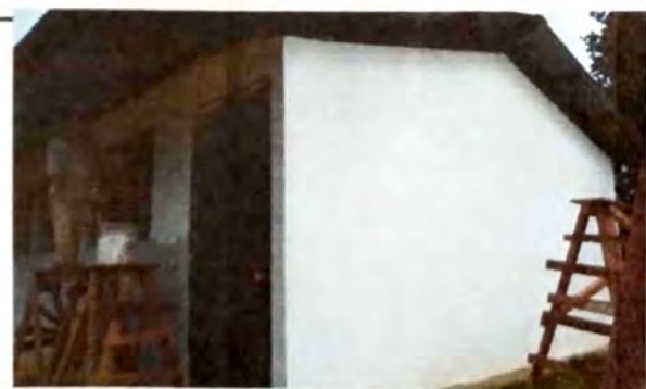
Modulo 1: Repello en paredes de aulas
