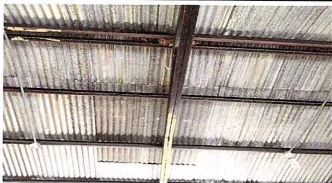
Foto 7: Mantenimiento a estructura de soporte de metal
