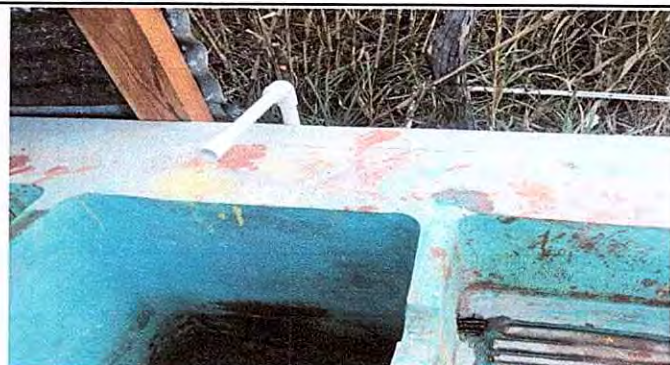
Foto 10: Sustitución de llave de chorro
