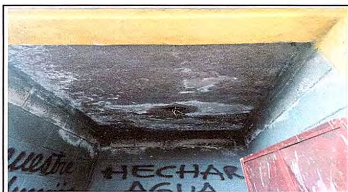
Foto 9: Impermeabilización de loza.
