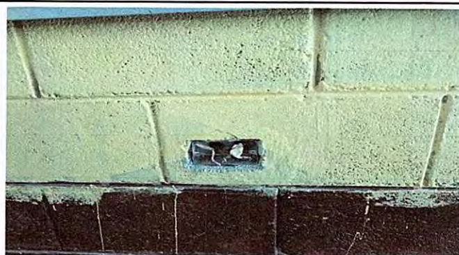
Foto 8: Sustitución de tomacorrientes dobles
