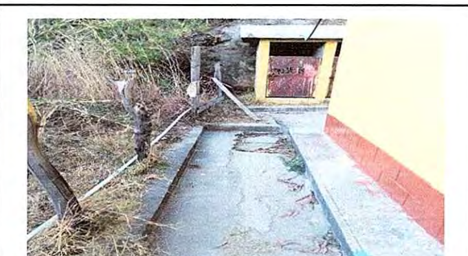
Foto 4: Reparación de cuneta de concreto
