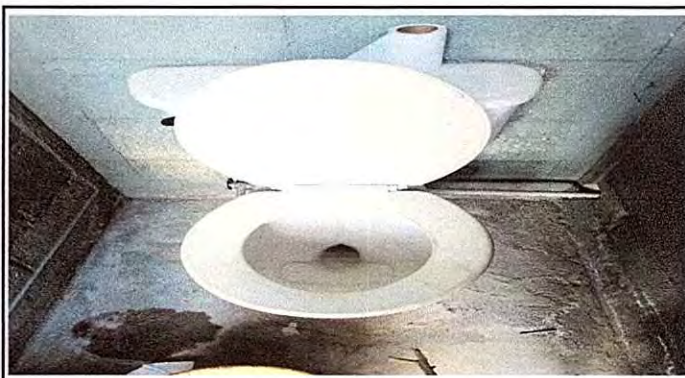
Foto 8: Sustitución de tapadera sanitario
