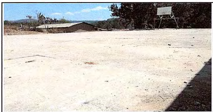
Foto 11: Reparación de plancha de concreto de patio
