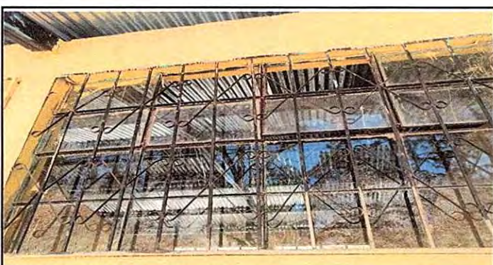
Foto 5: Mantenimiento a balcones de metal
