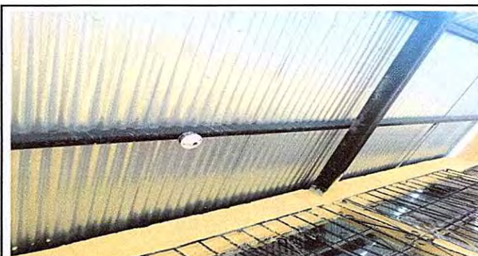
Foto 6: Sustitución de focos ahorradores
