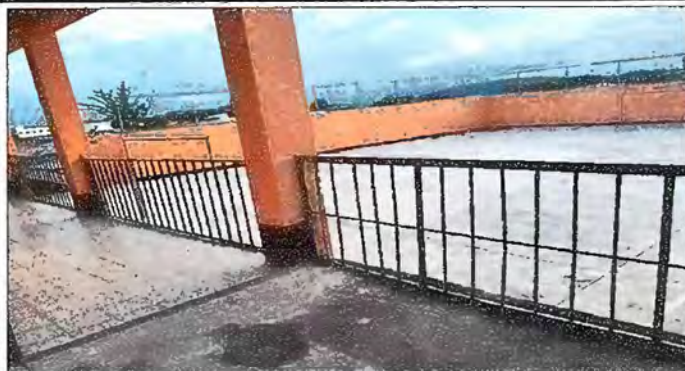
Modulo 1: Reparación de baranda.
