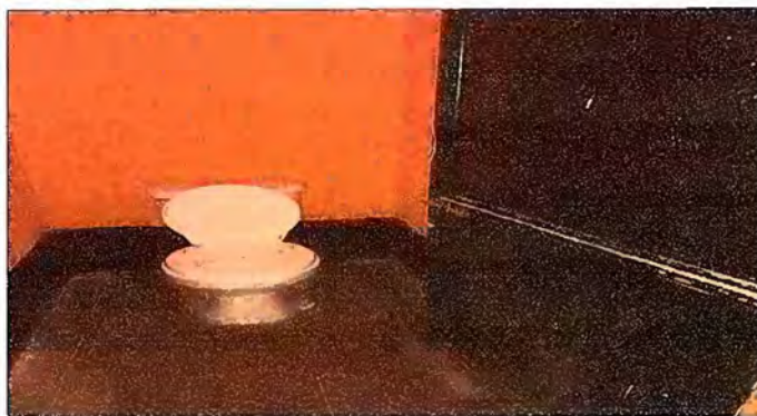
Modulo 2: sustitución de inodoros y accesorios.
