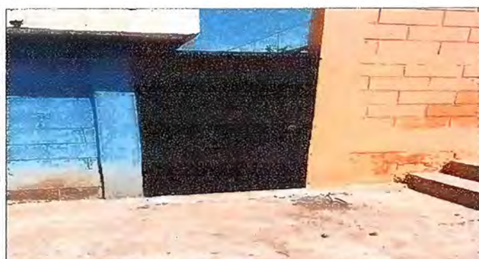
Modulo 1: Sustitución de puerta de madera por una de metal.
