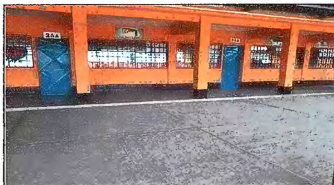
Modulo 3: suministro e instalación de balcones.
