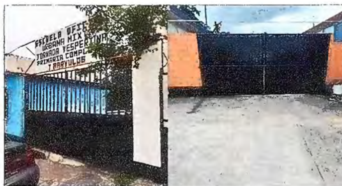
Modulo 1: Mantenimiento a portones de metal..
