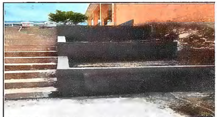
Modulo 1: Construcción de muro de contención paralelo a gradas de Ingreso principal No. 1
