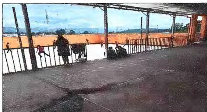
Modulo 1: Suministro e instalación de baranda.
