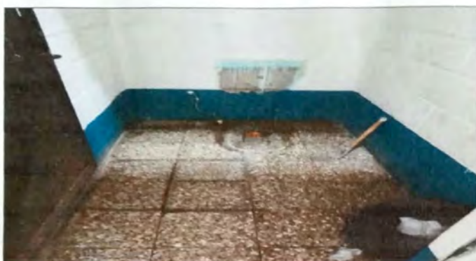
Modulo 2: sustitución de inodoros y accesorios.
