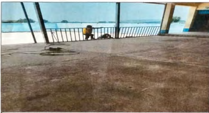
Modulo 1: Suministro e instalación de baranda.
