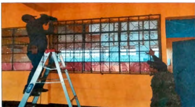
Modulo 3: suministro e instalación de balcones.
