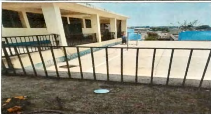
Modulo 1: Reparación de baranda.
