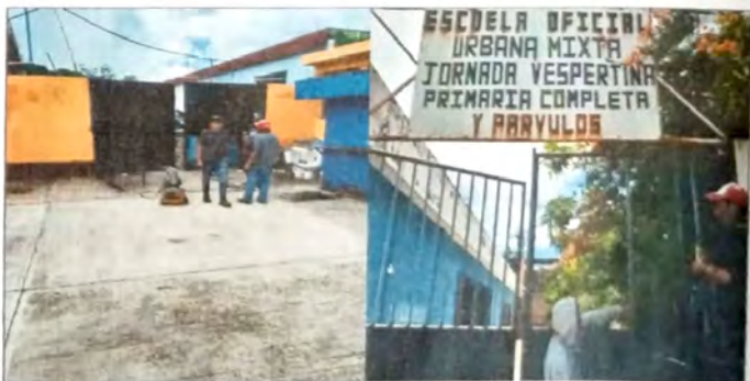
Modulo 1: Mantenimiento a portones de metal..
