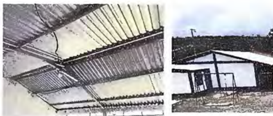
Modulo 1: sustitucion de estructura de soporte de metal por metal, sustitucion de de lamina por lamina calibre 26, elementos de fijacion, capote, canal de pvc focos
