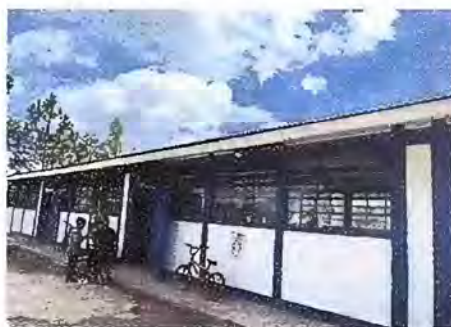
Modulo 5: sustitucion de canal pvc, pintura en muros interiores y exteriores, reparacion de banqueta de concreto, mantenimiento de puertas de metal.
