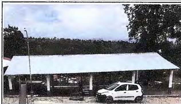
Modulo 2: sustitucion de lamina por lamina troquelada aluzinc calibre 26, sustitucion de estructura, elementos de fijacion, capote, focos ahorradores, mantenimiento de estructura.
