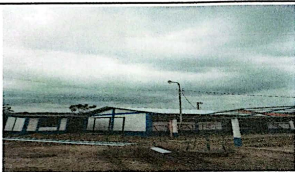
Módulo 1: Sustitución de vidrios
