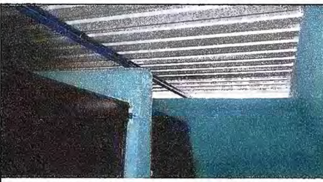
Foto 4 SUSTITUCIÓN DE LAMINA POR LAMINA TROQUELADA ALUZINC MODULO CALIBRE 26 FINALIZADO MODULO NO.1
