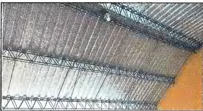
Foto 5: MANTENIMIENTO DE ESTRUCTURA REALIZADA MODULO No. 2
