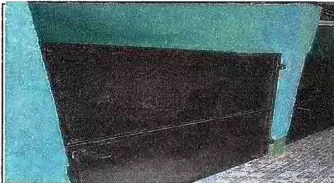
Foto 3: MANTENIMIENTO DE PUERTAS TERMINADAS No 1
