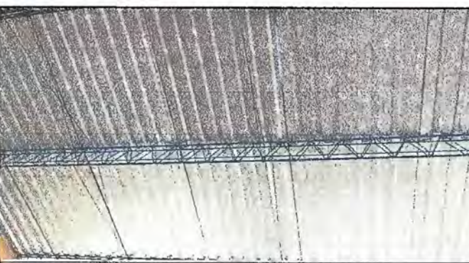
Foto 6: LAMINA TROQUELADA COLOCADA. MODULO No.2
