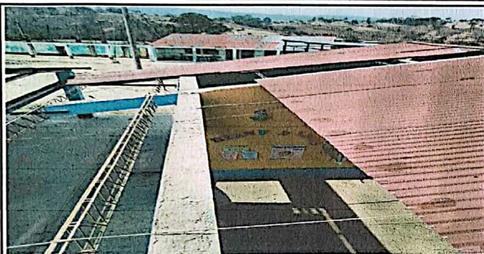
QUITADO DE LAMINA DE L MODULO 2
