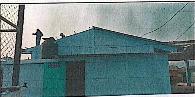
Foto 3: COLOCACION DE LAMINA TROQUELADA MODULO 2
