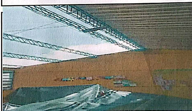
Foto 4: COLOCACIÓN DE UNA PARTE DE LAMINA TROQUELADA MODULO NO.2
