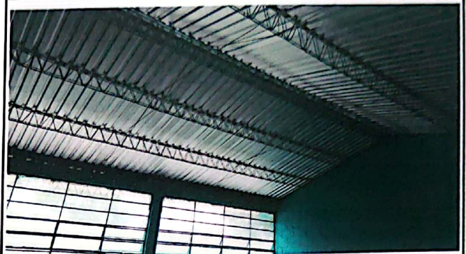
Foto 2: Aula en proceso de cambio de sistema eléctrico
