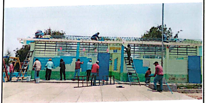
Foto 4: Trabajos de pintura
