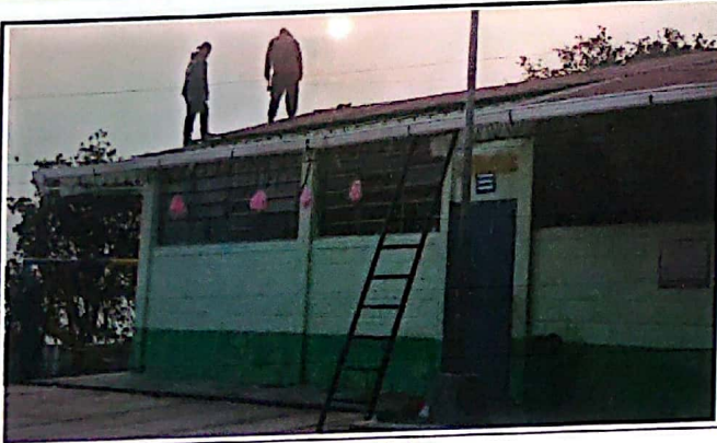
Foto 3: Realizandose trabajos en los módulos
