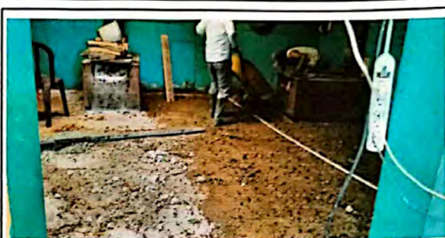
Módulo 1 Sustitución de torta de concreto.
