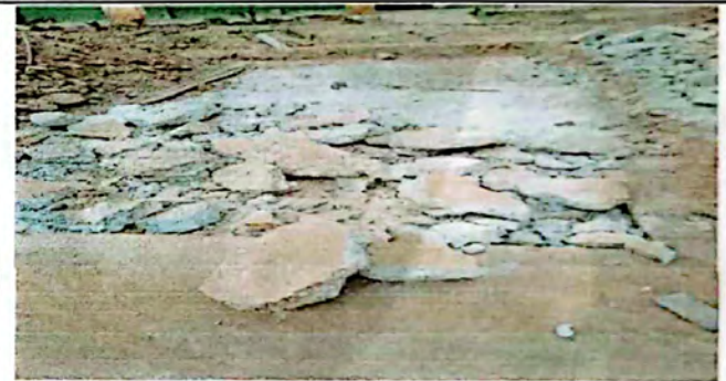
Módulo 3 reparación de torta de concreto cancha polideportiva.
