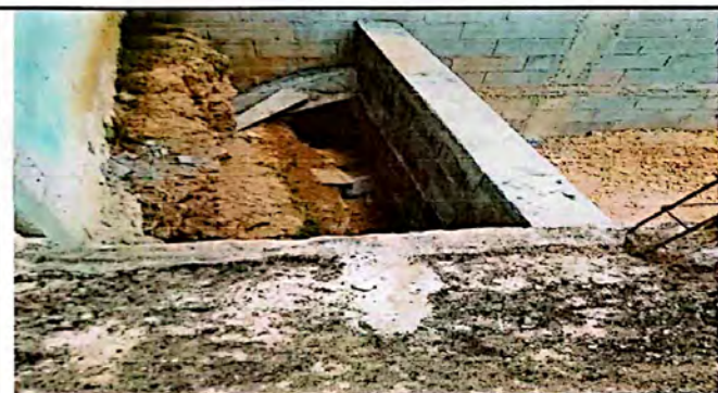
Módulo 1 Reparación de muro perimetral de block
