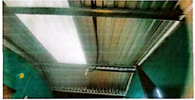
Módulo 2 Instalación de lámina troquelada aluzinc calibre 26 de 12 pies
