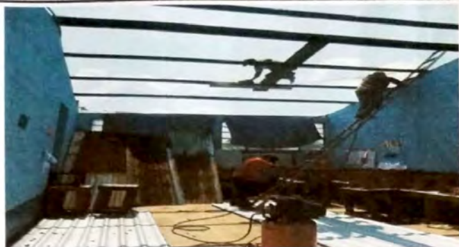
Foto 1: trabajos de pintura de costaneras en el modulo 1
