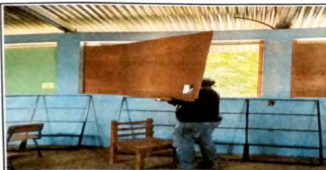
Foto 5: sustitucion de de ventanas en mal estado en modulo 4
