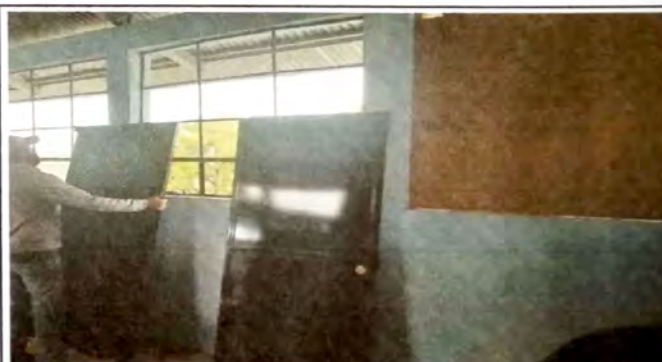
Foto 4: instalacion de puerta nuevas en el modulo 4
