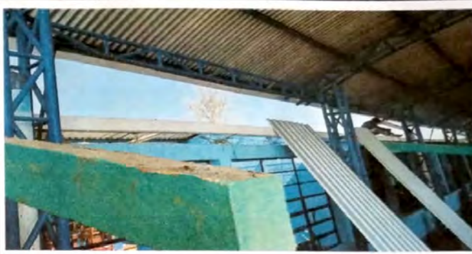
Foto 2: Instalacion de laminas troquelada calibre 26 en el modulo 1
