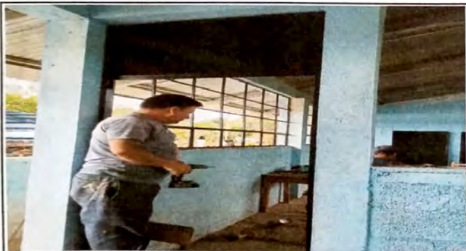
Foto 3: puesta de puertas en el modulo 4
