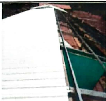
Foto 5: Sustitución de lámina y estructura de techo.
