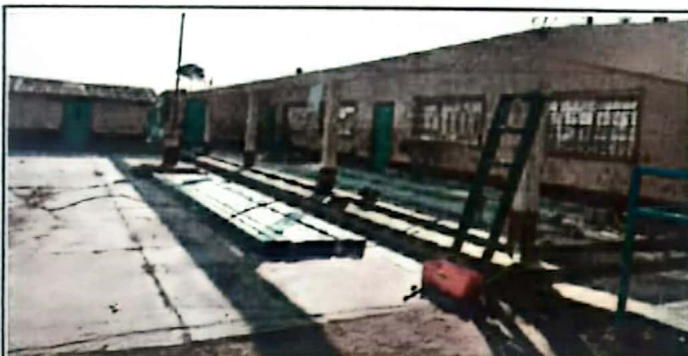
Foto 3: Sustitución de estructura de madera por metal.
