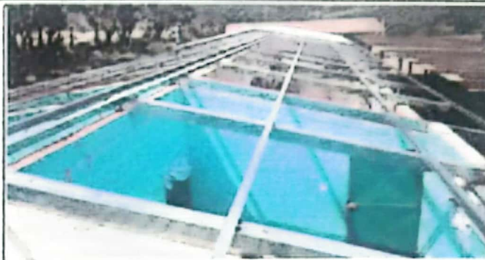
Foto 2: Sustitución de reglas y vigas de madera por costaneras de metal.
