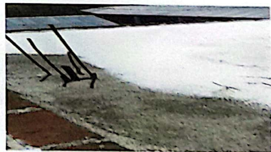
modulo 2: Impermeabilización de losa y cambio de lamparas led
