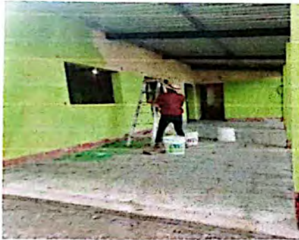
Foto 3: CUBIERTA DE LAMINA Y ESTRUCTURA DE TECHO
