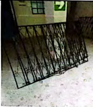
Foto 1: CUBIERTA DE LAMINA, ESTRUCTURA DE TECHO, PUERTAS DE METAL, VENTANAS, PISO, CANALES, BAJADAS DE AGUA PLUVIAL, PINTURAS EN MUROS INTERIORES Y EXTERIORES Y REPARACION DE
