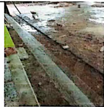
Foto 6: CUNETAS DE CONCRETO
