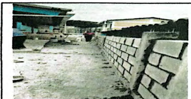
Foto 5: Sustitución de barandas de metal
