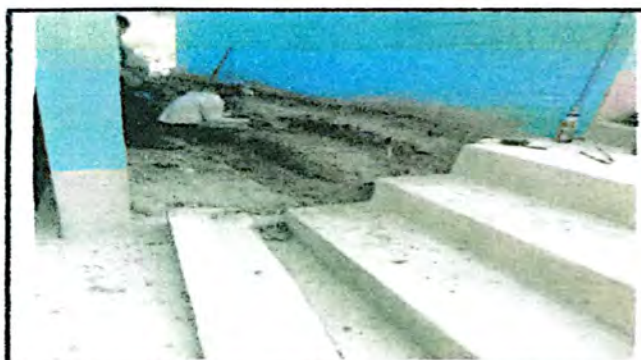
Foto 4: Reparación de banqueta de concreto
