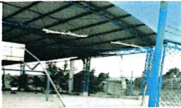
Foto 9: Sustitución de lamparas tipo led
