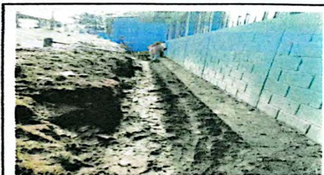
Foto 3: Reparación de banqueta de concreto
