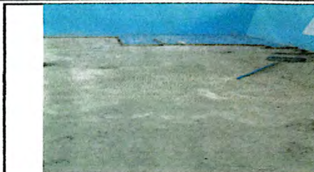
Foto 2: Sustitución de piso de granito
