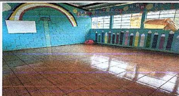
Foto 3, Módulo 1: Sustitución de piso cerámico
