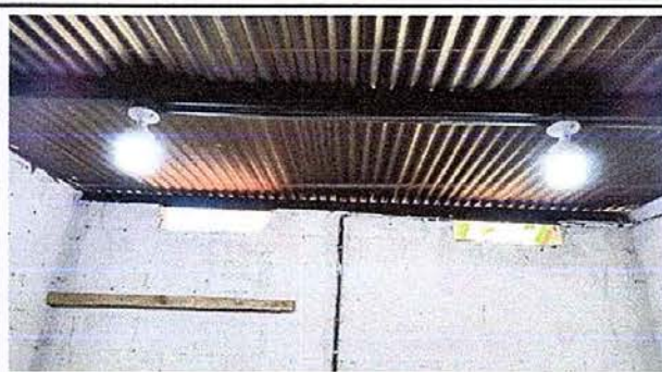
Foto 8, modulo 2: Instalacion de unidades de Luz
