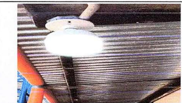
foto 10, Módulo 2: sustitucion de Focos
