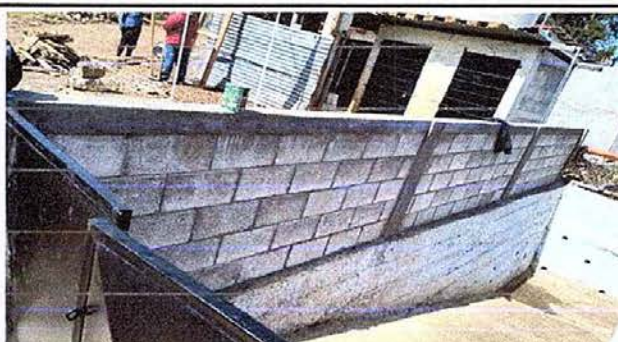
Foto 14, Muro Perimetral: Reparacion de Muro Perimetral
