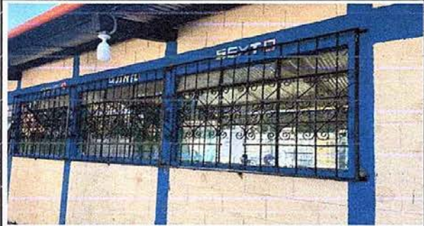
Foto 2, módulo 1: suministro e instalacion de balcon de hierro en ventana
