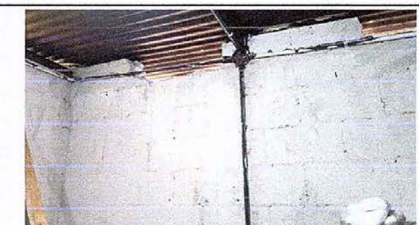
Foto 12, Módulo 2: Reparacion de Cableado Electrico
