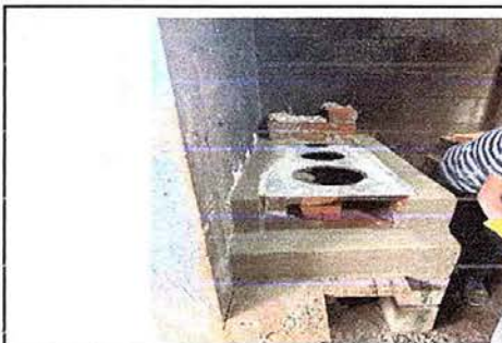
Foto 6, Módulo 2: Sustitución de plancha de metal de 3 hornillas
