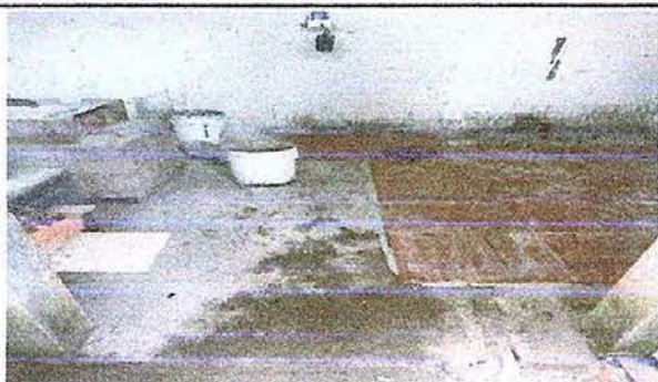
Foto 7, Módulo 2: sustitución de piso de cemento liquido por piso ceramico
