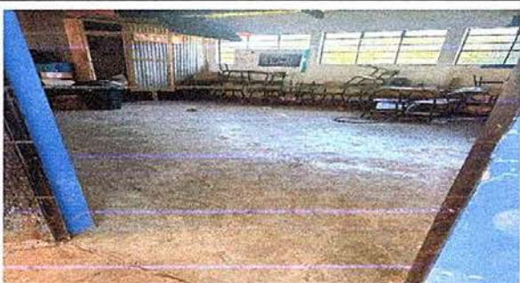
Foto 3, Módulo 1: Sustitución de piso cerámico
