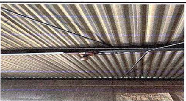
Foto 12, Módulo 2: Reparacion de Cableado Electrico
