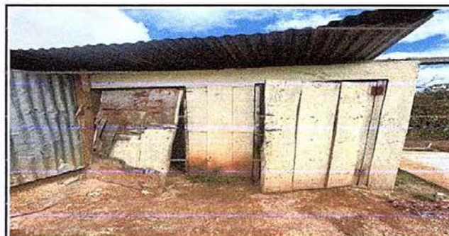
Foto 18, Modulo 3: Sustitucion de puertas en servicio Sanitario
