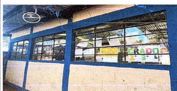
Foto 2, modulo 1: suministro e instalacion de balcon de hierro en ventana
