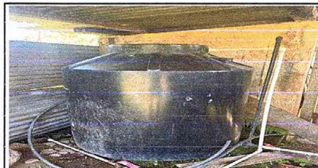
Foto 16, Areas Exteriores: sustitucion de Depósito de Agua
