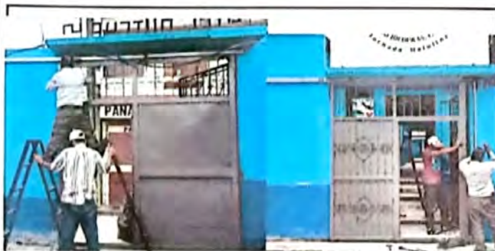
MÓDULO III- Sustitución de portones principales doble hoja por corredizas.
