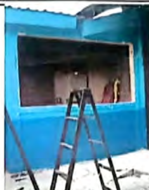
MÓDULO II- Apertura de vano, ventana balcón
