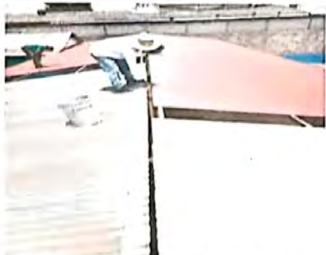
MÓDULO I- Sustitución de lámina troquelada calibre 26
