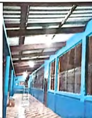
MÓDULO IV- Sustitución de accesorios de energía eléctrica
