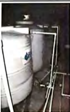
MÓDULO V y VI- Suministro de tinaco de área de pila y cocina
