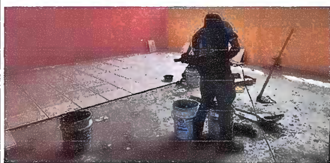
Foto 5: colocacion de piso ceramico
