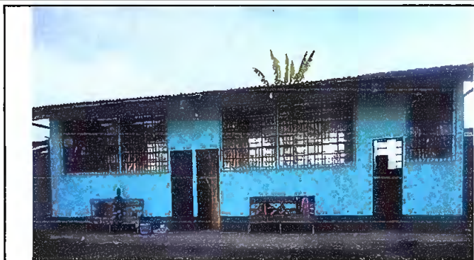
Foto1: Pintura en interiores y exteriores.
