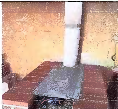
Foto 9: Sustitucion de plancha y remodelacion de base.
