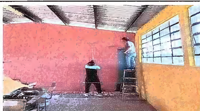
Foto 4: Aplicación de pintura en interiores y exteriores.
