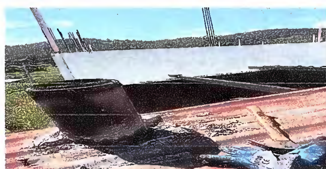
Foto 6: Desinstalacion de lamina existente e instalacion de lamina troquelada calibre 26.
