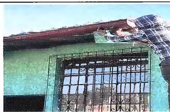
Foto 2: Mantenimiento de líneas de canal y bajadas de aguas pluviales.
