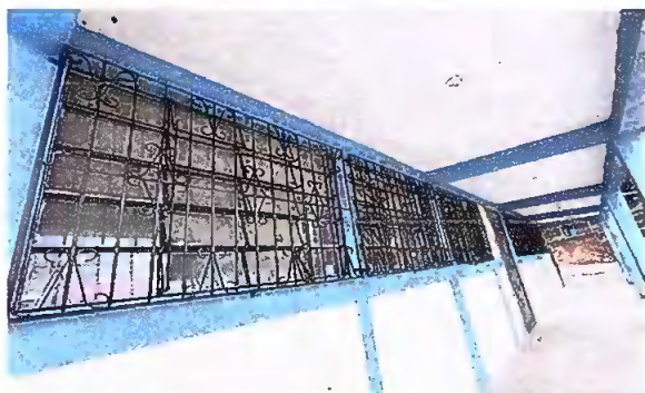
Foto 3: Instalacion de balcones en ventanas de aulas.
