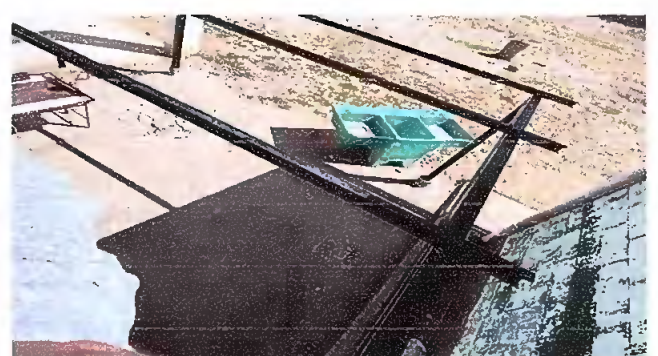
Foto 10: Sustitucion e instalacion de pila concreto cemento.
