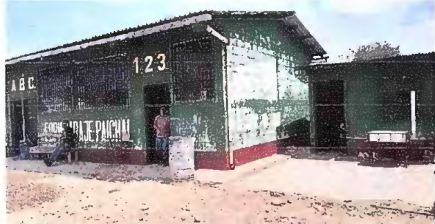
Foto 1: Pintura en interiores y exteriores.
