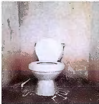
Foto 13: Instalacion de 2 unidades de inodoro.
