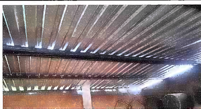
Foto 8: Desinstalacion de lamina existente e instalacion de lamina troquelada calibre 26.
