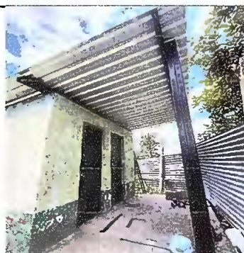
Foto 12: Desinstalacion de lamina existente e instalacion de lamina troquelada calibre 26.
