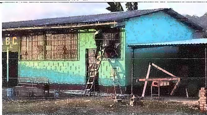
Foto1: Pintura en interiores y exteriores.
