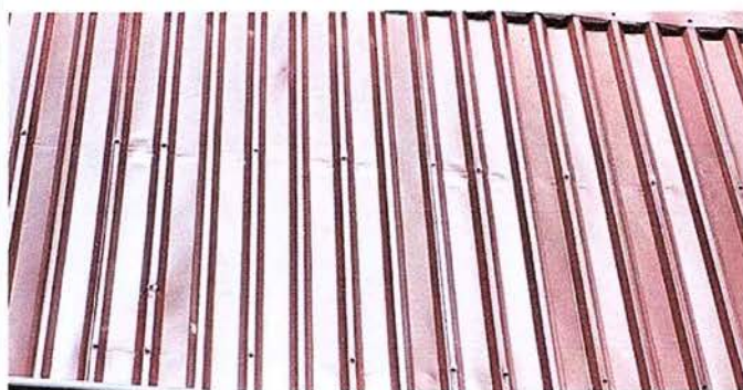
Foto 15. Módulo 2: Finalización de sustitución de elementos de fijación (tornillos).
