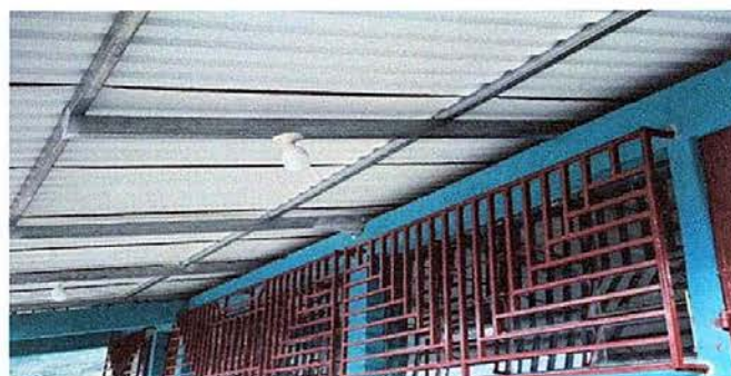
Foto 8. Módulo 1: Finalización de sustitución de focos ahorradores.
