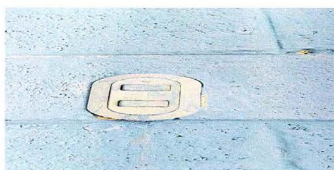
Foto 10. Módulo 1: Finalización de sustitución de interruptores.
