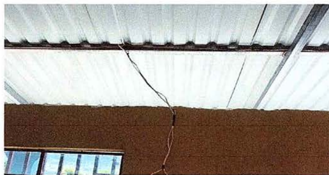
Foto 16. Módulo 2: Finalización de reparación de cableado.
