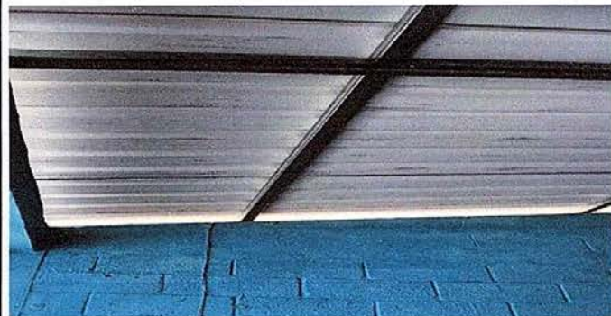
Foto 2. Módulo 1: Finalización de sustitución de estructura de soporte de metal por metal.
