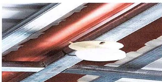
Foto 9. Módulo 1: Finalización de sustitución de plafonera.
