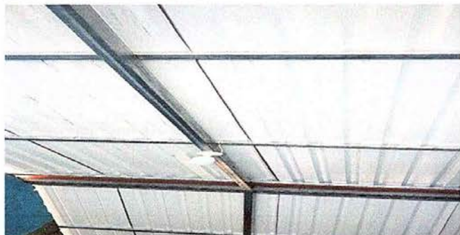
Foto 13. Módulo 2: Finalización de sustitución de estructura de soporte de metal por metal.
