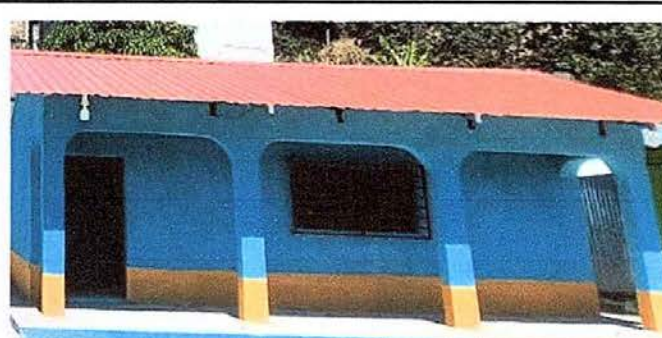
Foto 12. Módulo 2: Finalización de sustitución de lámina por lámina troquelada.
