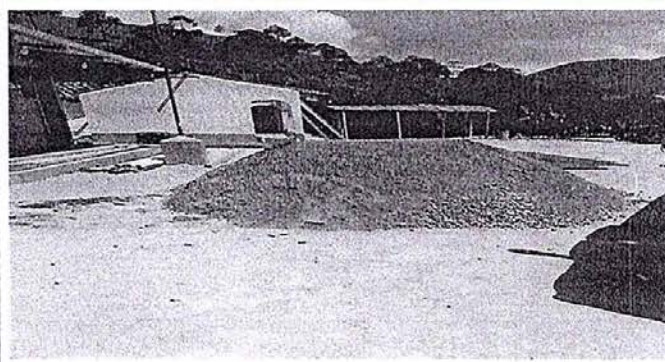
Foto 20. Módulo 3: Reparación de torta de concreto.
