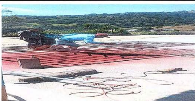
Foto 5. Módulo 1: Suministro e instalación de balcones de metal.
