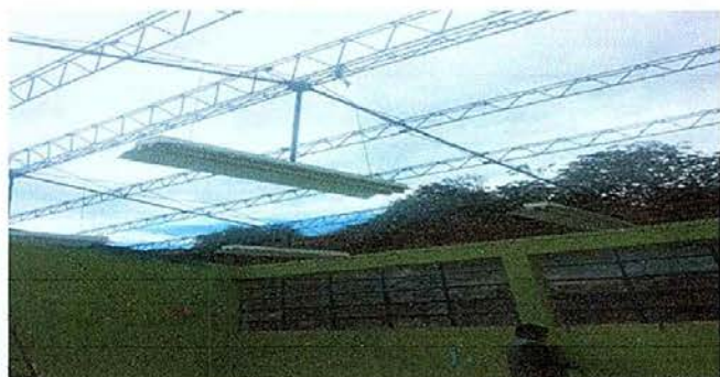
Foto 7. Módulo 1: Sustitución de ducto eléctrico.
