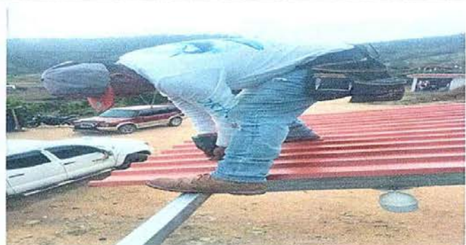
Foto 4. Módulo 1: Sustitución de elementos de fijación (tornillos).
