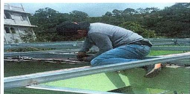
Foto 15. Módulo 2: Reparación de cableado.
