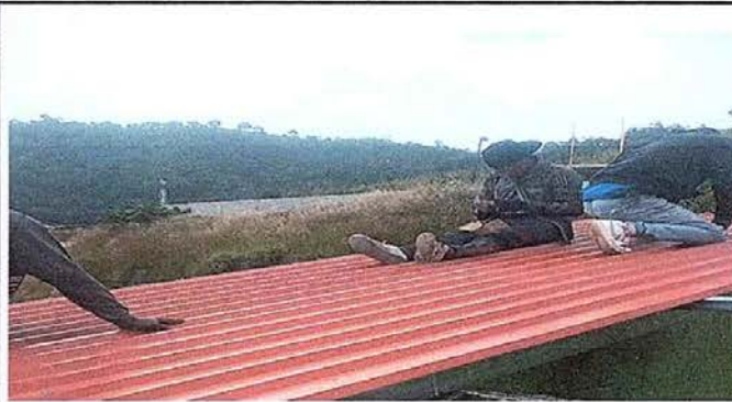
Foto 14. Módulo 2: Sustitución de elementos de jifación (tornillos)
