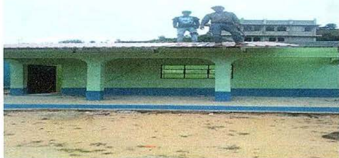
Foto 11. Módulo 2: Sustitución de lámina por lámina troquelada.
