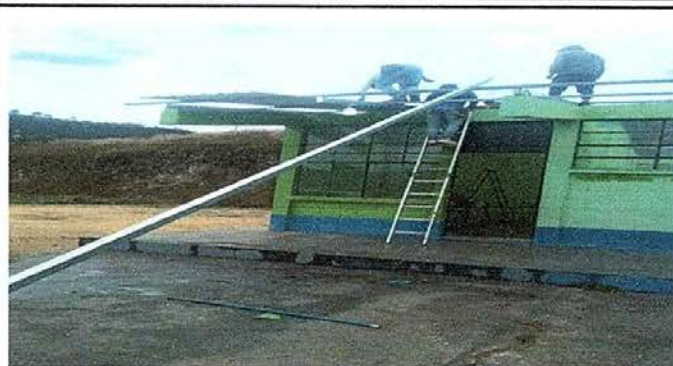
Foto 2. Módulo 1: Sustitución de estructura de soporte de metal por metal.
