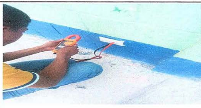
Foto 10. Módulo 1: Sustitución de tomacorrientes.
