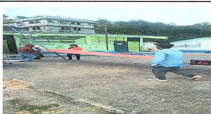
Foto 1. Módulo 1: Sustitución de lámina por lámina troquelada.
