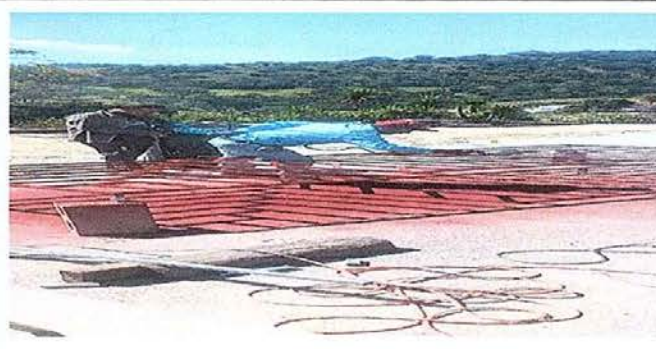
Foto 16. Módulo 2: Sustitución de ducto eléctrico.
