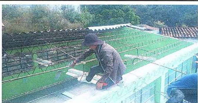
Foto 6. Módulo 1: Reparación de cableado.
