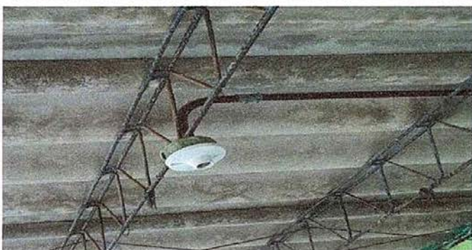
Foto 9. Módulo 1: Sustitución de plafoneras.
