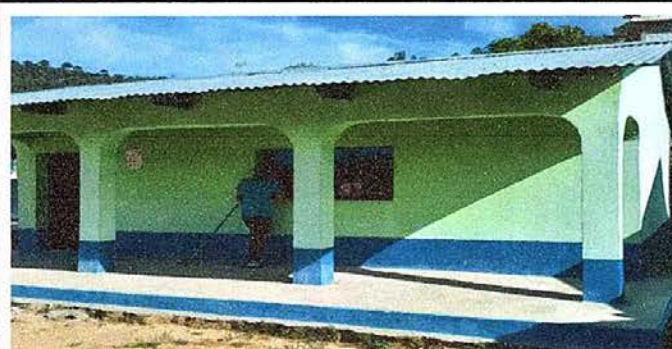
Foto 23. Pintura de muros interiores y exteriores.
