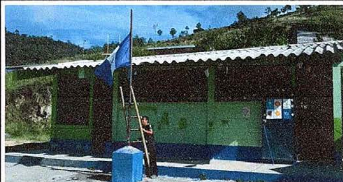
Foto 22. Pintura de muros interiores y exteriores.
