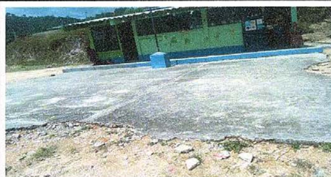
Foto 21. Módulo 3: Reparación de torta de concreto.
