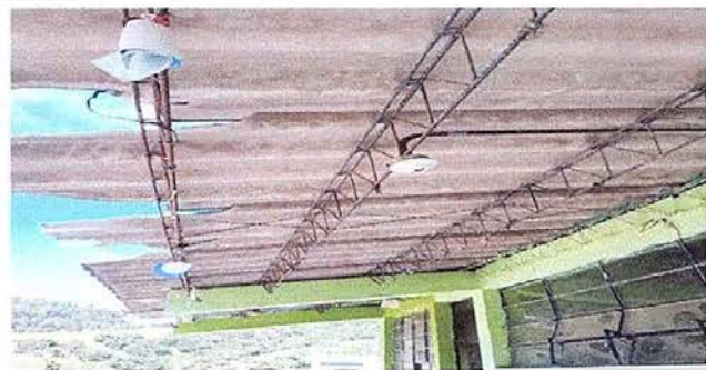
Módulo 1. Foto 1: Sustitución de lámina por lámina troquelada.
