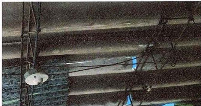
Foto 7. Módulo 1: Sustitución de ducto eléctrico.
