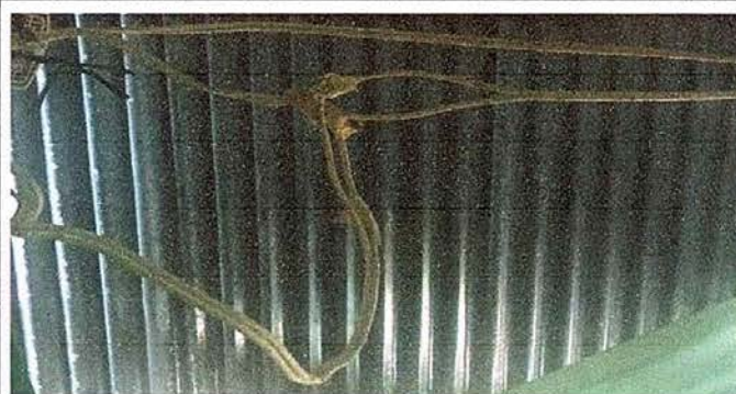
Foto 16. Módulo 2: Reparación de cableado.
