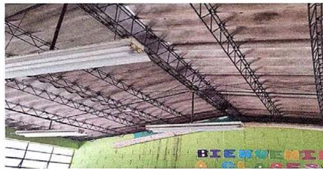
Módulo 1. Foto 2: Sustitución de estructura de soporte de metal por metal.
