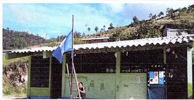
Foto 6: Pintura en muros exteriores e interiores.
