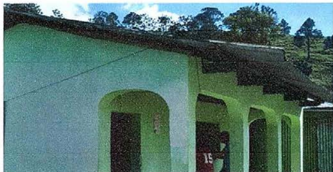
Foto 13. Módulo 2: Sustrución de estructura de soporte de metal por metal.
