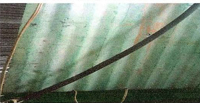
Foto 17. Módulo 2: Sustrución de ducto eléctrico.
