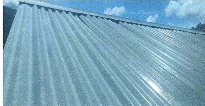
Foto 14. Módulo 2: Sustrución de capote de lámina por capote de lámina troquelada.
