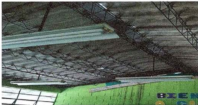
Foto 8. Módulo 1: Sustitución de focos ahorradores.
