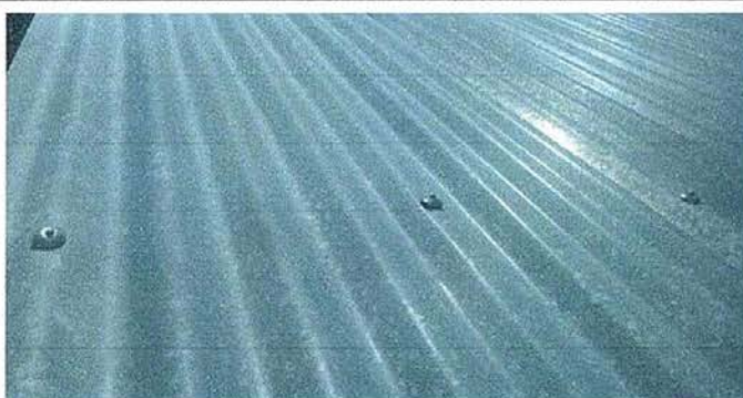
Foto 15. Módulo 2: Sustrución de elementos de fijación (tornillos).
