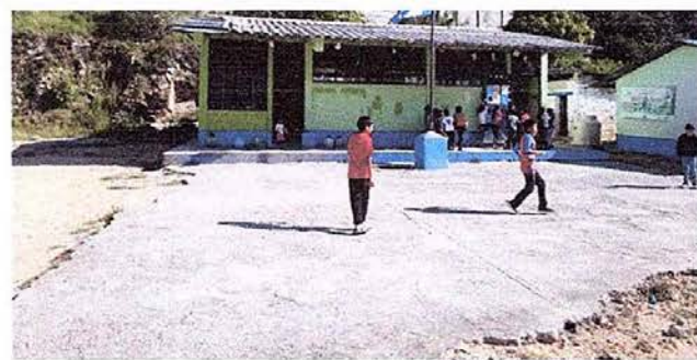
Módulo 3. Foto 5: Sustitución de torta de cemento por torta de cemento.
