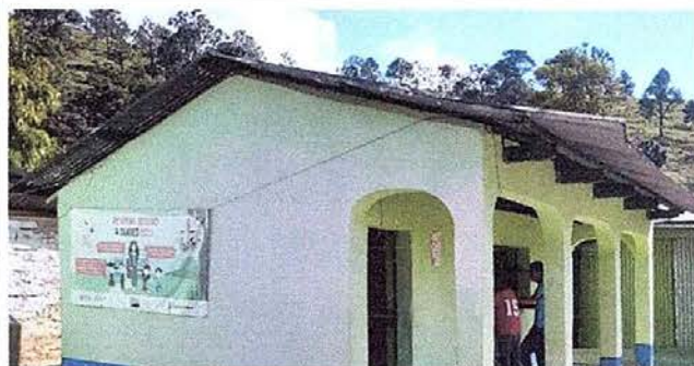
Módulo 2. Foto 4: Sustitución de estructura de soporte de metal por metal.
