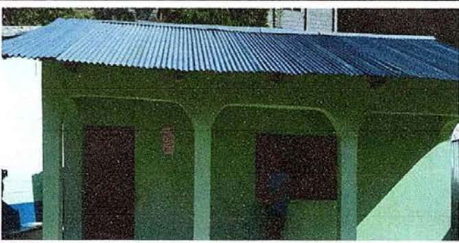
Foto 12. Módulo 2: Sustitución de lámina por lámina troquelada.
