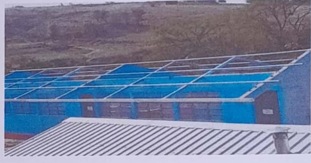
Foto 4: Instalacion de balcones parte de afuera
