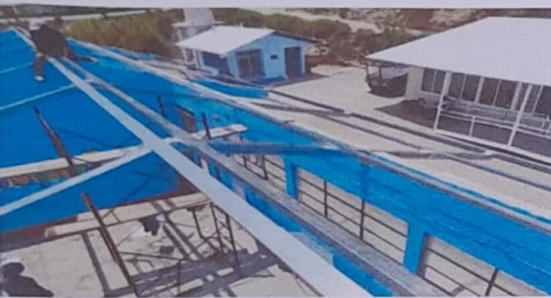
Foto 3: Sustitución de estructura de soporte de metal
