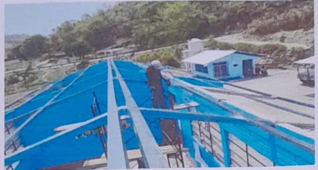
Foto 2: Instalación de Balcones
