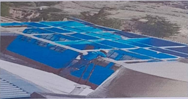
Foto 5: Cambio de pintura
