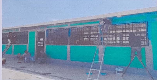
Foto 6: Instalación de balcones
