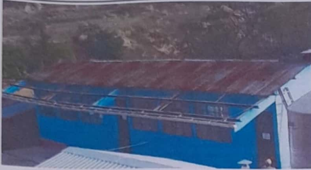
Foto1: Cambio de Techo
