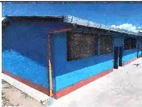
Foto 6: Módulo 1 Sustitución de canal terminado
