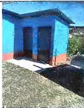
Foto 11: Módulo 3 Estructura de puertas terminado
