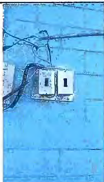
Foto 3: Módulo 1 Sustitución de flipón realizado
