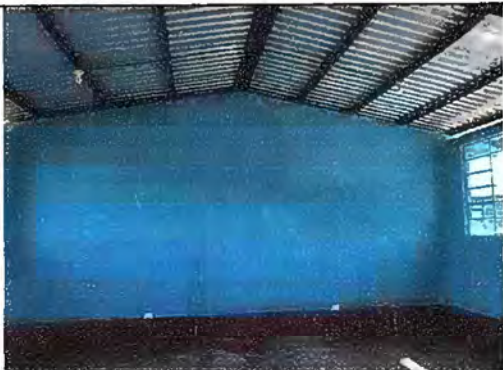
Foto 7: Módulo 1 Estructura de soporte de metal realizado
