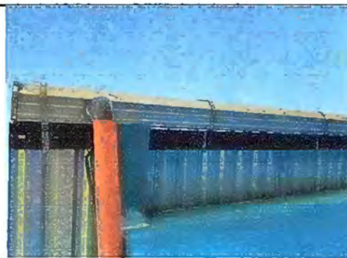
Foto 6: Módulo 1 En proceso de sustitución de canal.
