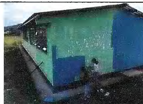
Foto 12: Proceso de pintura general de muros interior y exterior
