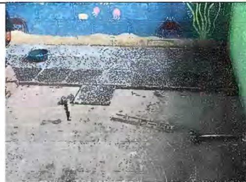
Foto 10: Módulo 2 Proceso de sustitución de piso de torta de concreto, por piso de granito.
