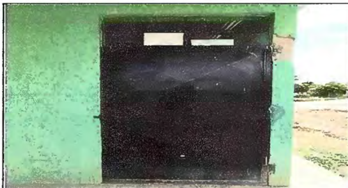
Foto 9: Módulo 2 mantenimiento a estructura de puertas
