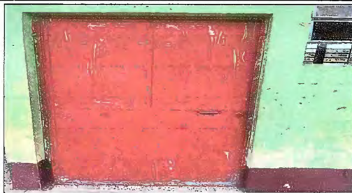
Foto 8: Módulo 1 mantenimiento a estructura de puertas
