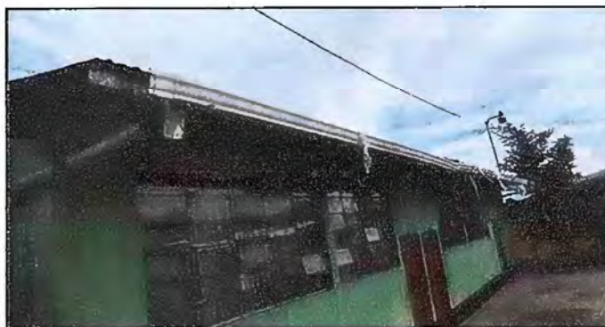
Foto 6: Módulo 1 Sustitución de canal.
