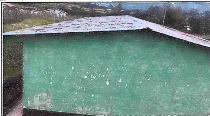
Foto 2: Módulo 1 Sustitución de capote de lámina.
