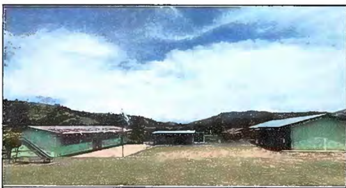
Foto 12: Pintura general de muros interior y exterior
