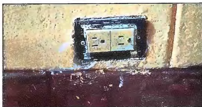
Foto 5: Módulo 1 Sustitución de toma corrientes dobles.
