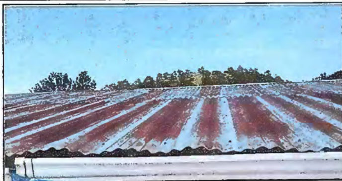
Foto 1: Módulo 1 Sustitución de lámina, por lámina troquelada.
