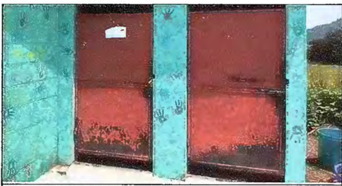
Foto 11: Módulo 3 mantenimiento a estructura de puertas
