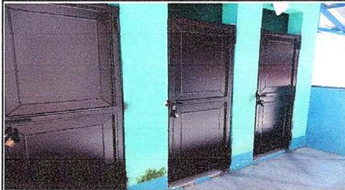
Foto 2: Módulo 2 Sustitución de puertas
