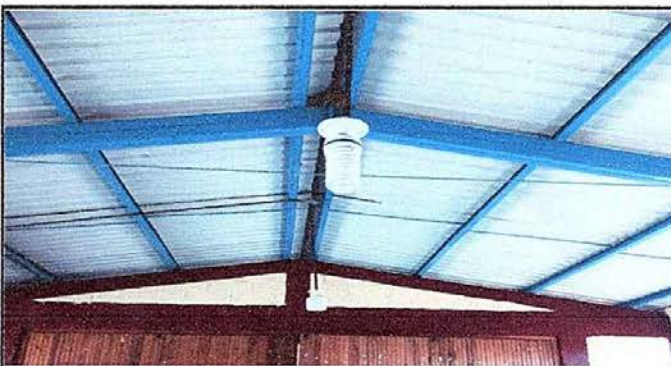
Foto 12: Reparación de cableado eléctrico general
