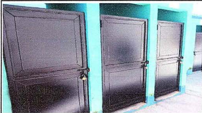
Foto1: Módulo 1 Sustitución de puertas
