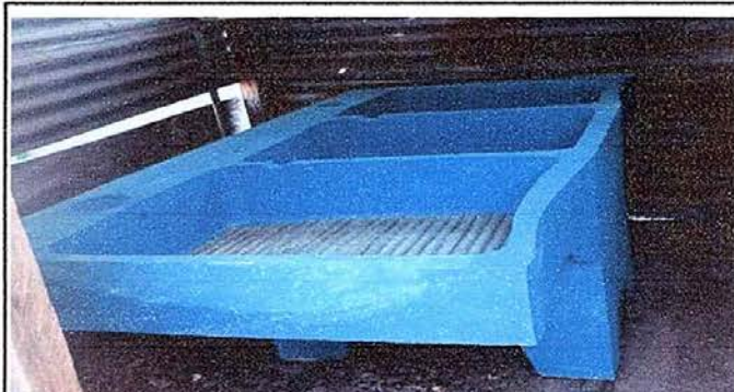
Foto 8: MÓDULO 6 Sustrución de Pila
