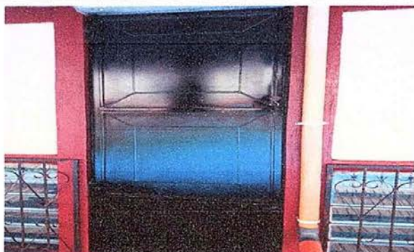
Foto 3: Modulo 3 Sustitución de puertas
