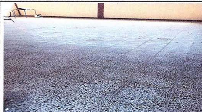
Foto 4: Módulo 3 Sustitución de piso
