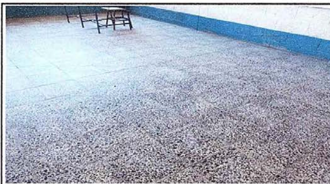
Foto 10: MÓDULO 7 Sustrución de piso
