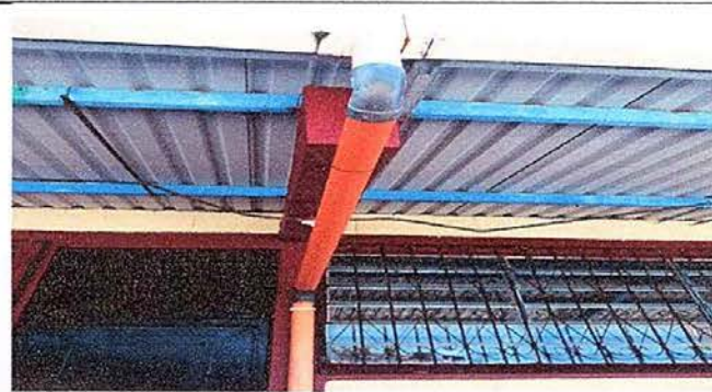
Foto 6: MÓDULO 3 Reparación de bajadas de agua pluvial
