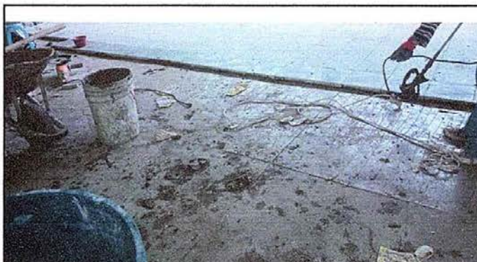
Foto 10: MÓDULO 7 Sustrucción de piso
