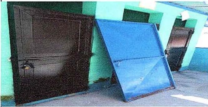
Foto 1: Módulo 1 Sustitución de puertas
