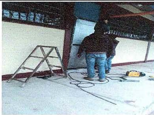
Foto 3: Módulo 3 Sustitución de puertas
