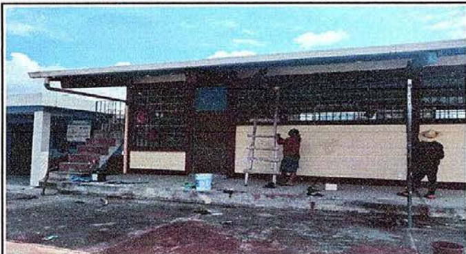
Foto 13: Pintura de muros interiores y exteriores
