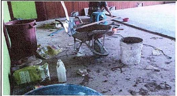
Foto 4: Módulo 3 Sustitución de piso
