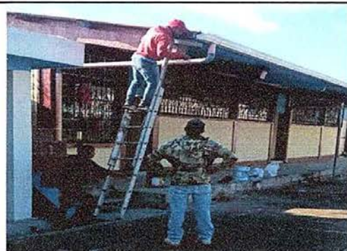
Foto 6: MÓDULO 3 Reparación de bajadas de agua pluvial
