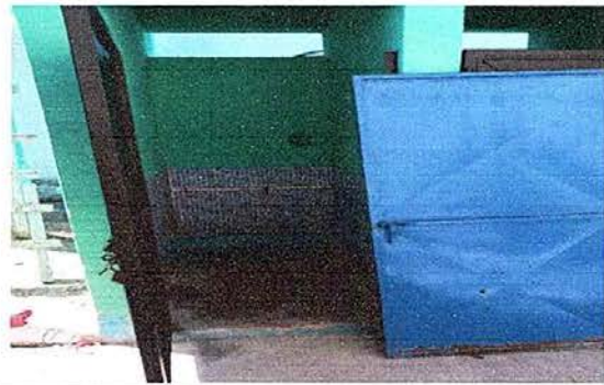
Foto 2: Módulo 2 Sustitución de puertas
