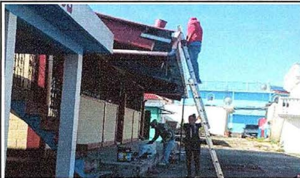
Foto 5: MÓDULO 3 Reparación de canales
