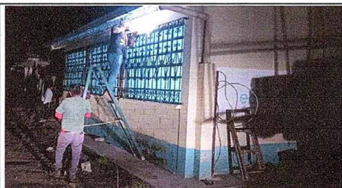
Foto 9: MÓDULO 7 Suministro e instalación de Balcones
