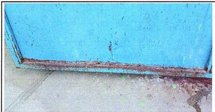
Foto 3: Módulo 3 Sustitución de puertas
