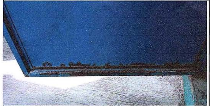
Foto 2: Módulo 2 Sustitución de puertas
