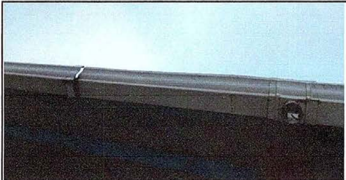
Foto 5: MÓDULO 3 Reparación de canales
