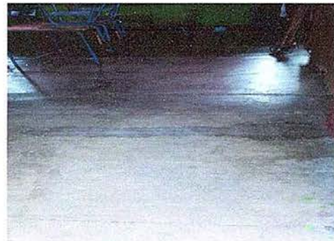
Foto 4: Módulo 3 Sustitución de piso
