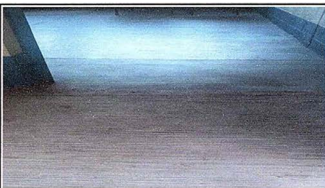
Foto 10: MÓDULO 7 Sustitución de piso
