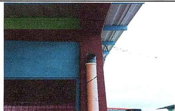
Foto 6: MÓDULO 3 Reparación de bajadas de agua pluvial
