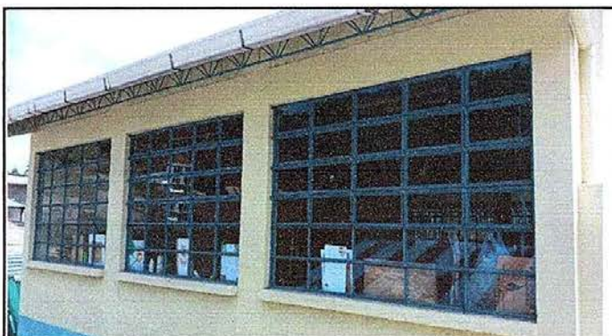
Foto 9: MÓDULO 6 Suministro e instalación de Balcones
