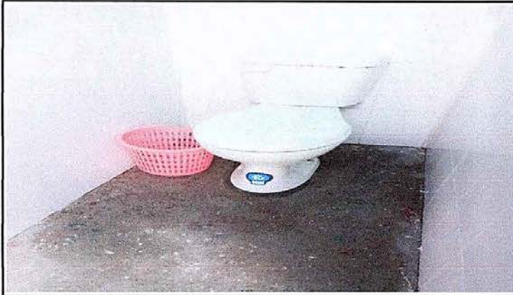
Foto 13 Módulo 3: Sustitución de inodoros
