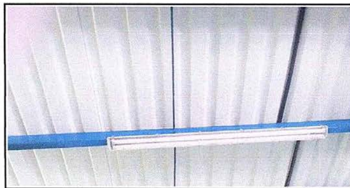
Foto 12 Módulo 2: Reparación de lámparas
