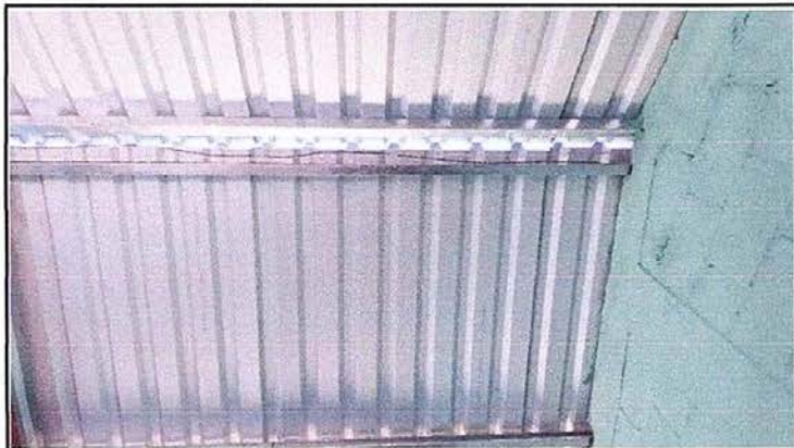
Foto 7 Módulo 1: Reparación de cableado eléctrico
