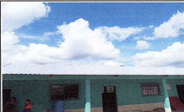
Foto 1 Módulo 1: Sustrucción de lámina por lámina troquelada aluzinc cal 26
