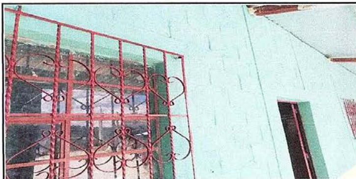
Foto 5 Módulo 1: Mantenimiento a balcones de metal
