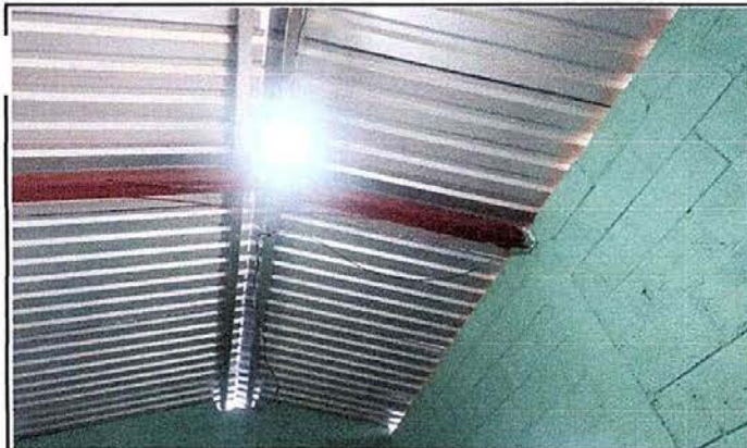
Foto 8 Módulo 1: Reparación de lámparas
