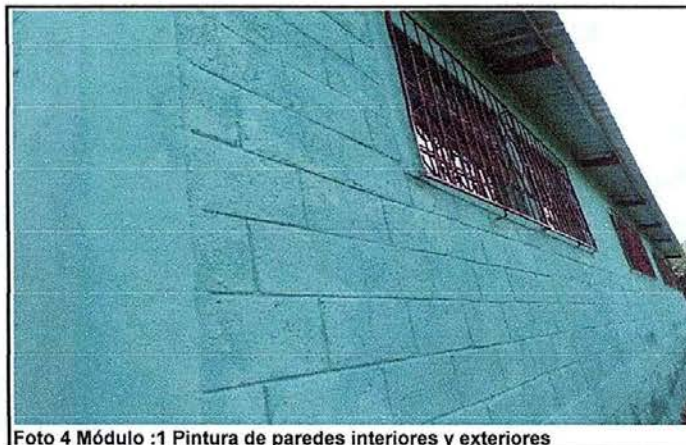
Foto 4 Módulo 1: Pintura de paredes interiores y exteriores
