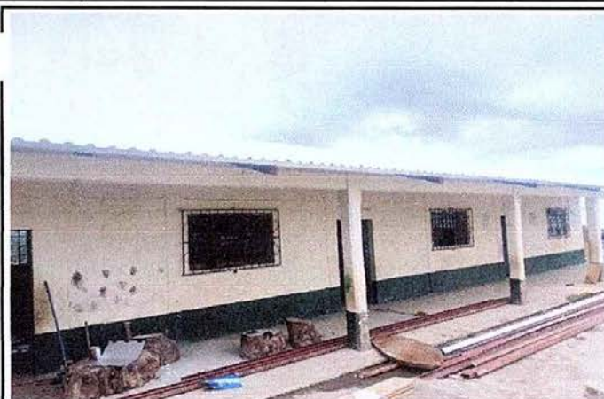
Foto 2 Módulo 1: Sustitución de capote para lámina troquelada
