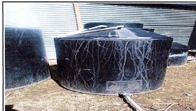
Foto 16 Módulo 3: Sustitución de depósito de agua No. 1 (1700 LTS)
