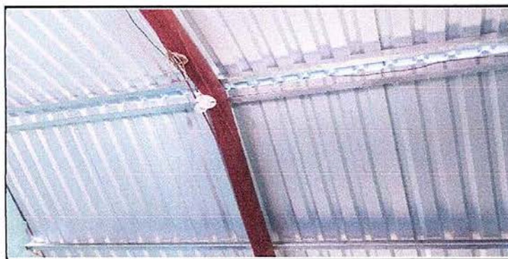
Foto 11 Módulo 2: Reparación de cableado eléctrico
