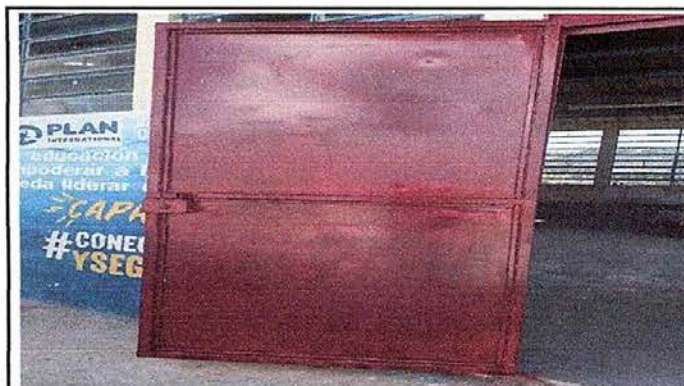
Foto 10 Módulo 2: mantenimiento a estructura de puerta lijado y aplicación de pintura
