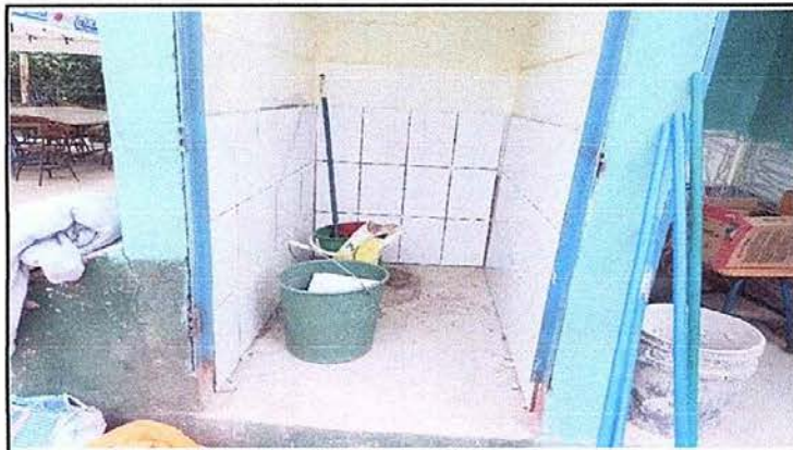
Foto 13 Módulo 3: Sustitución de inodoros
