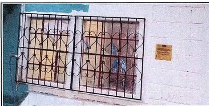
Foto 5 Módulo 1: Mantenimiento a balcones de metal
