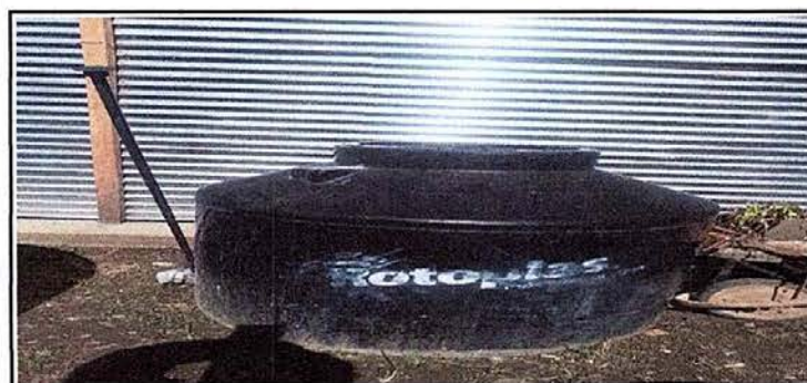
Foto 17 Módulo 3: Sustitución de depósito de agua No.2 (1700 LTS)
