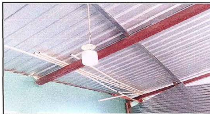
Foto 12 Módulo 2: Reparación de lámparas
