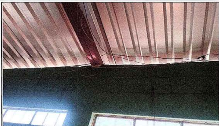
Foto 7 Módulo 1: Reparación de cableado eléctrico
