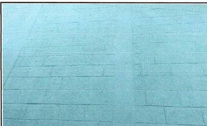
Foto 4 Módulo :1 Pintura de paredes interiores y exteriores
