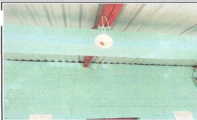
Foto 8 Módulo 1: Reparación de lámparas
