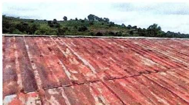
Foto 2 Módulo 1: Sustitución de capote para lámina troquelada
