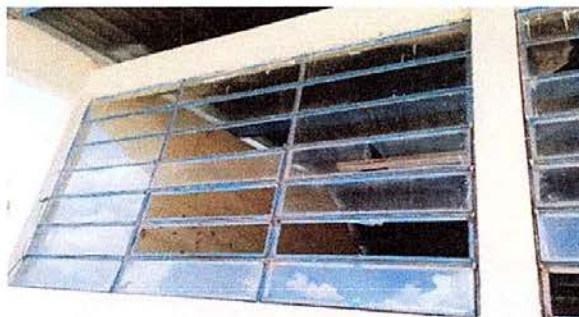
Foto 9 Módulo 2: sustitución de vidrios
