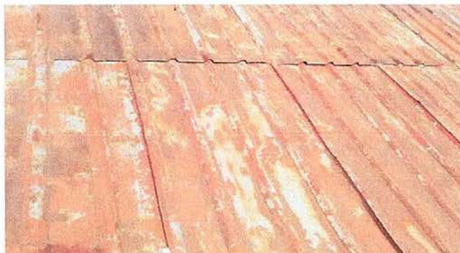
Foto 1 Módulo 1: Sustitución de lámina por lámina troquelada aluzinc cal 26
