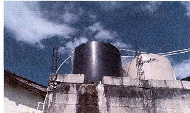
Foto 16 Módulo 3: Sustitución de depósito de agua No. 1 (1700 LTS)
