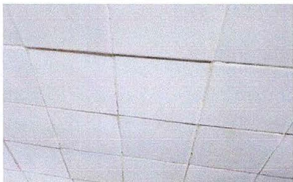
Foto 15 Módulo 3: Sustitución de azulejos
