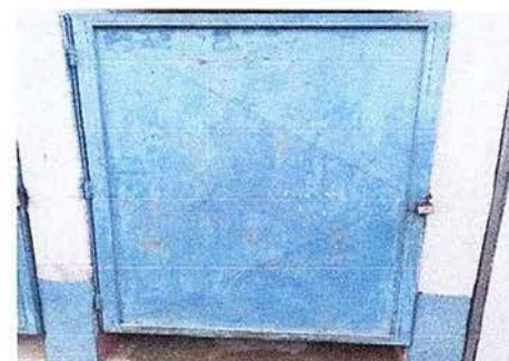
Foto 18 Módulo 3: Mantenimiento a estructura de puerta lijado y aplicación de pintura
