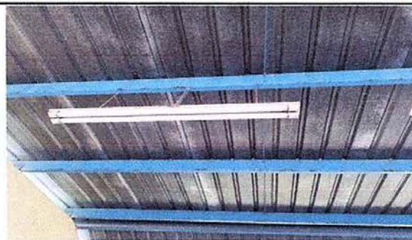
Foto 12 Módulo 2: Reparación de lámparas
