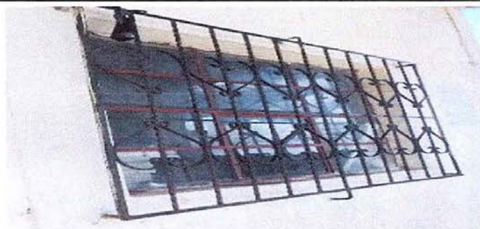
Foto 5 Módulo 1: Mantenimiento a balcones de metal
