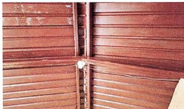
Foto 8 Módulo 1: Reparación de lámparas
