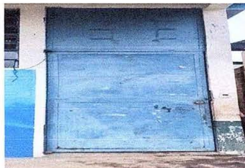
Foto 10 Módulo 2: mantenimiento a estructura de puerta lijado y aplicación de pintura
