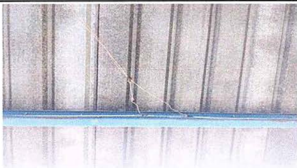
Foto 11 Módulo 2: Reparación de cableado eléctrico
