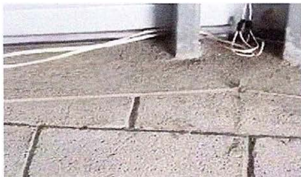
Foto 7 Módulo 1: Reparación de cableado eléctrico
