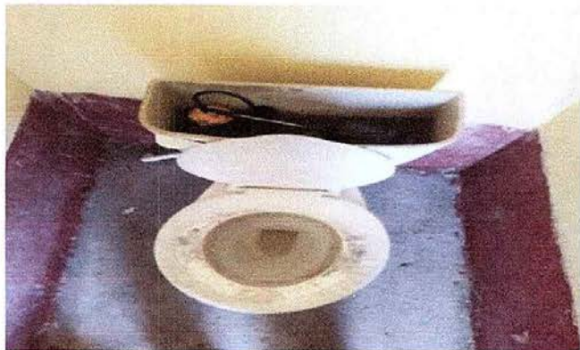
Foto 13 Módulo 3: Sustitución de inodoros
