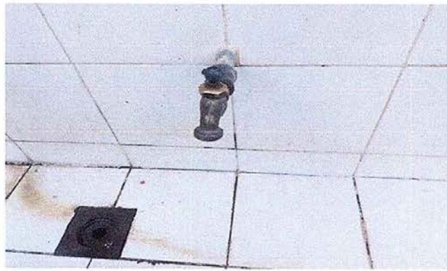
Foto 14 Módulo 3: Sustitución de llave de chorro
