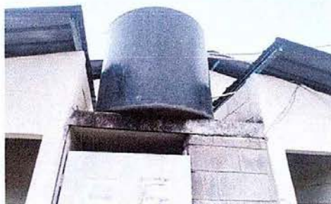
Foto 17 Módulo 3: Sustitución de depósito de agua No.2 (1700 LTS)
