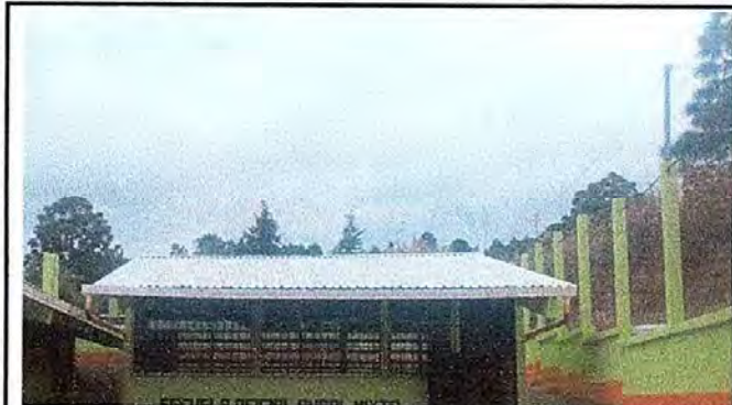
Modulo 1: Foto. 1 Sustitución de lámina, por lámina troquelada alizinc calibre 26, sustitución de capote de lámina y sustitución de elementos de fijación (tornillos)
