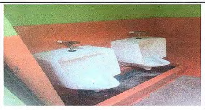
Modulo 4: fot.2 Sustitución de mingitorio
