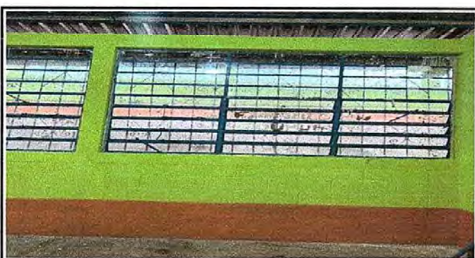
Modulo 1: Foto. 5 Sustitución de vidrio
