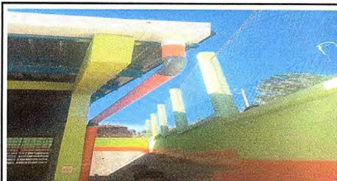
modulo 1: Foto 3. Sustitución de canal pvc.
