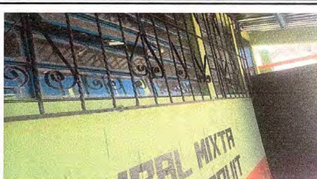
Modulo 1: Foto 2. Mantenimiento a balcones de metal.
