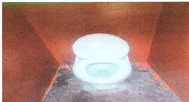
Modulo 4: fot.4 Sustitucion de inodoro.
