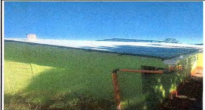
Modulo 2: foto. 1 Sustitución de canal pvc y reparación de bajada de agua pluvial pvc 3.
