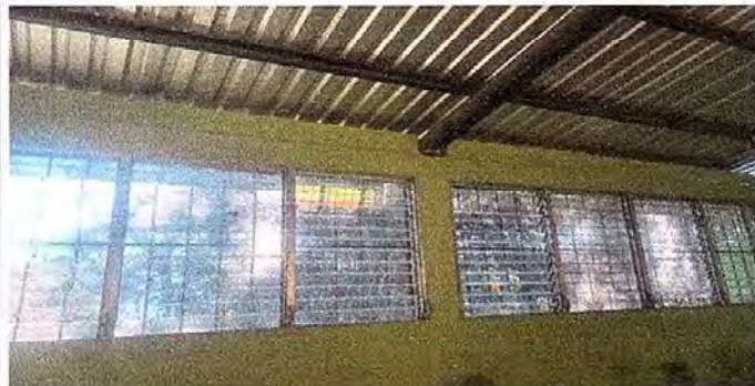
Modulo 3: foto4 sustitucion de vidrios.
