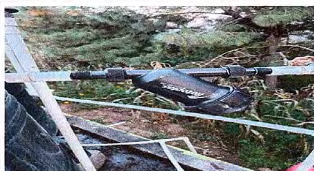
modulo 4. fot.6 sustitucion de filtro para llenado de deposito rotoplas y accesorio.
