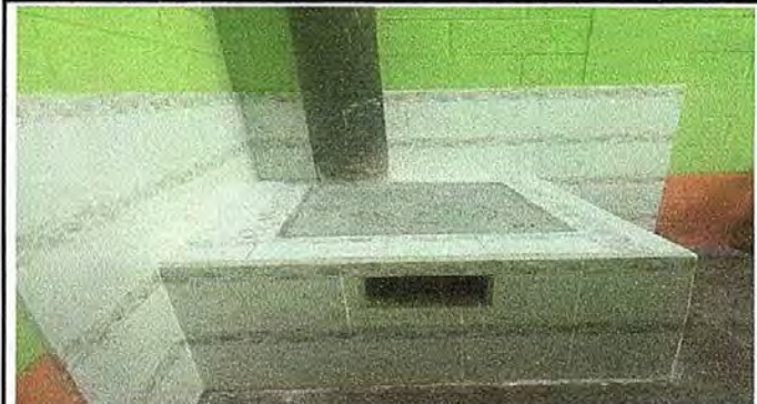
Modulo 2: foto 3. Mantenimiento a estufa rural, intalacion de azulejoa estufa rural y Sustitucion de plancha de metal 3 hornillos
