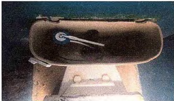
modulo 4: fot.3Sustitucion de accesorio inodoro. (contrallave, tubo de abasto y tanque)
