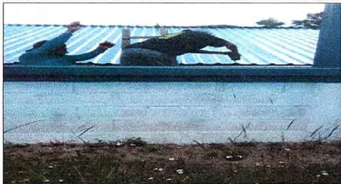
Modulo 1: Foto. 1 Sustitución de lámina, por lámina troquelada al zinc calibre 26, sustitución de capote de lámina y sustitución de elementos de fijación (tornillos)
