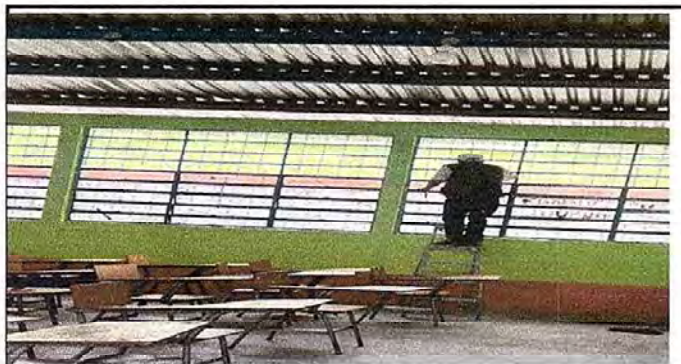
Modulo 1: Foto. 5 Sustitución de vidrio
