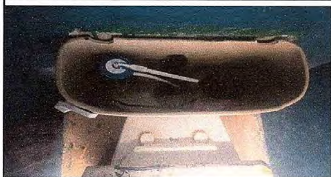
modulo 4: fot.3 Sustitucion de accesorio inodoro. (contrallave, tubo de abasto y tanque)
