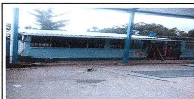
Modulo 3: foto1 Sustitucion de lámina, por lamina troquelada aluzinc calibre 26, sustitucion de capote de lamina, sustitucion de elementos de fijación (tornillos)
