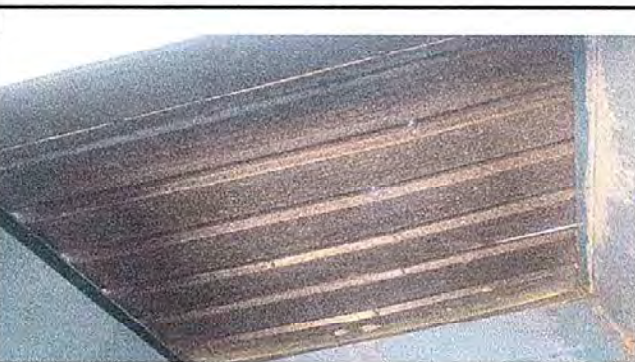
Modulo 4: fot. 1 Sustitución de lámina, por troquelada aluzinc calibre 26, sustitucion de elementos de fijación (tornillos)
