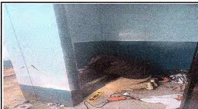
Modulo 4: fot.2 Sustitución de mingitorio
