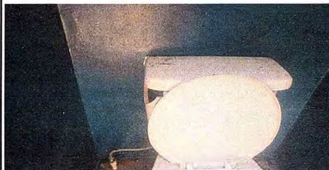
Modulo 4: fot.4 Sustitucion de inodoro.
