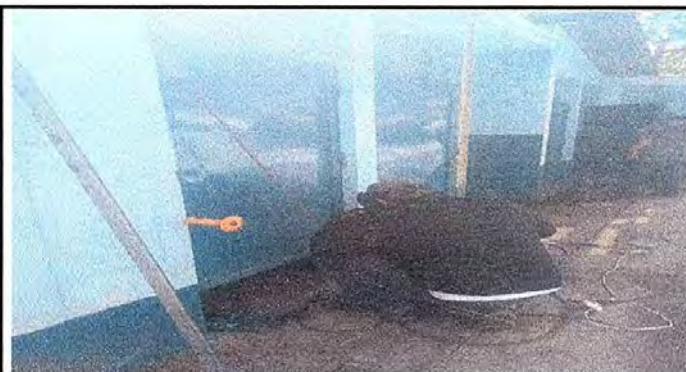
Modulo 4: fot.5 Mantenimiento a estructura de puerta (lijado, cepillado y pintado)
