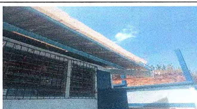
Modulo 1: Foto 2. Mantenimiento a balcones de metal.
