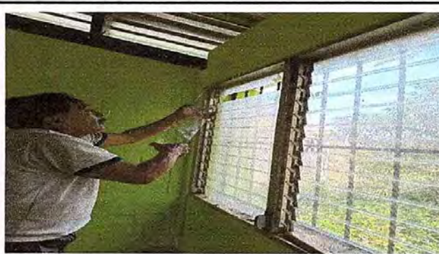
Modulo 3: foto4 sustitucion de vidrios.
