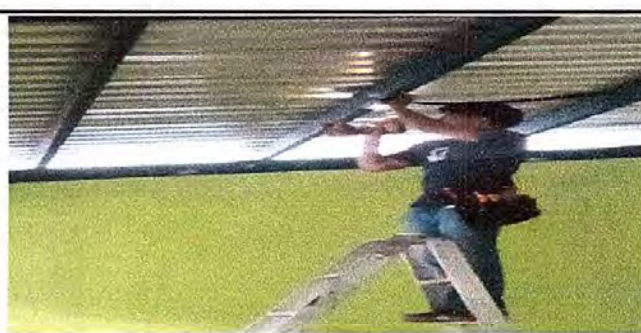
Modulo 3: foto2 sustitucion de lámparas 2x20, reparación de cableado eléctrico, instalacion de unidades de luz.
