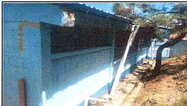
Modulo 2: foto. 1 Sustitución de canal pvc y reparación de bajada de agua pluvial pvc 3.
