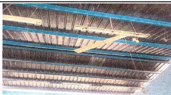
Modulo 1: Foto. 4.Sustitución de lámparas de 2x40, reparación del cableado eléctrico e Instalación de unidades de luz.
