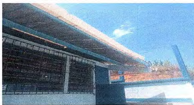
Modulo 1: Foto 2. Mantenimiento a balcones de metal.
