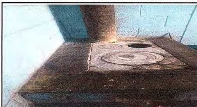
Modulo 2: foto 3. Mantenimiento a estufa rural, intalacion de azulejoa estufa rural y Sustitucion de plancha de metal 3 hornillos
