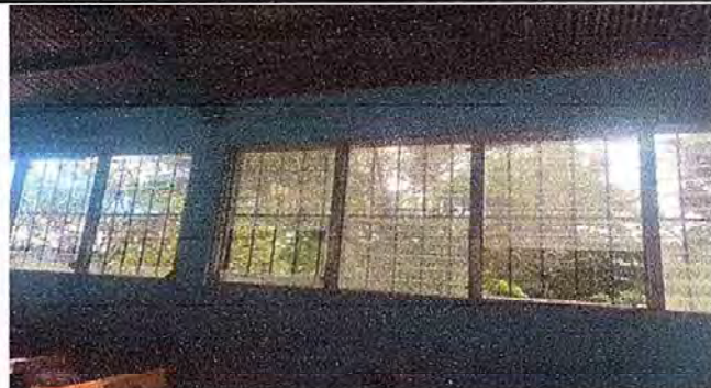
Modulo 3: foto4 sustitucion de vidrios.
