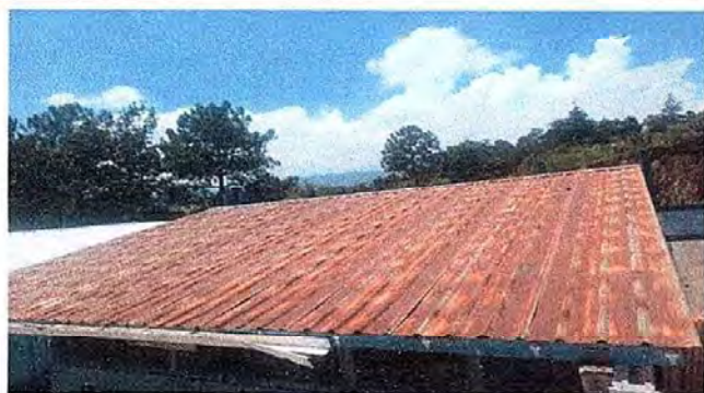
Modulo 1: Foto. 1 Sustitucion de lámina, por lámina troquelada alizinc calibre 26, sustitución de capote de lámina y sustitucion de elementos de fijación (tornillos)
