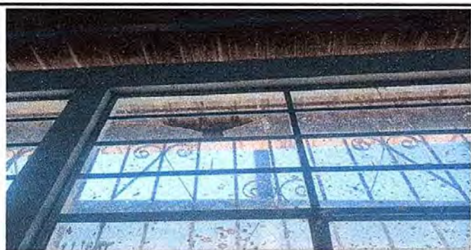
Modulo 1: Foto. 5 Sustitución de vidrio
