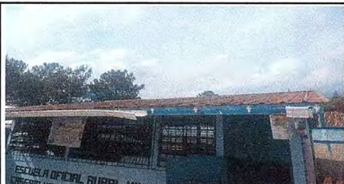
modulo 1: Foto 3.Sustitucion de canal pvc.
