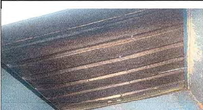
Modulo 4: fot. 1 Sustitución de lámina, por troquelada aluzinc calibre 26, sustitucion de elementos de fijación (tornillos)
