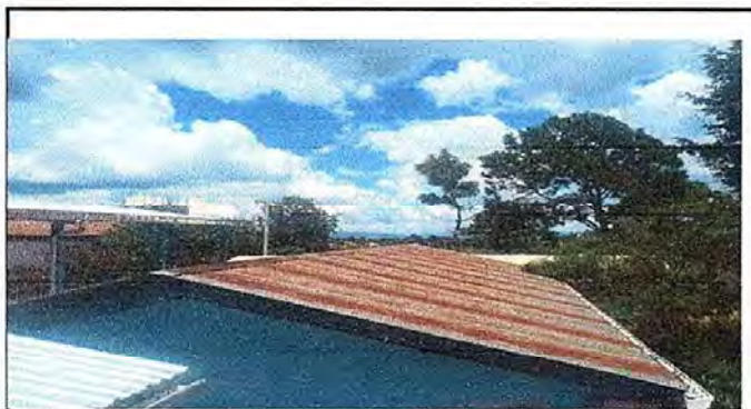
Modulo 3: foto1 Sustitucion de lámina, por lamina troquelada aluzinc calibre 26, sustitucion de capote de lamina, sustitucion de elementos de fijación (tornillos)
