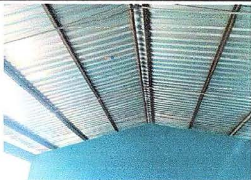
Foto No. 7, Módulo No. 2. Sustitución de lámina, por lámina troquelada aluzinc calibre 26, desinstalación de lámina.
