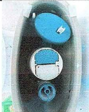
Foto No. 22, Módulo No. 4. Sustitución de accesorios de inodoro (contra llave, manguera de abasto y tanque.
