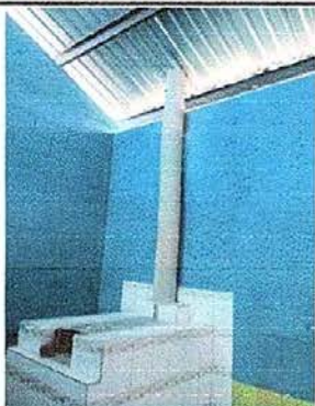
Foto No. 13, Módulo No. 3. Sustitución de chimenea de concreto y sustitución de lámina por lámina troquelada aluzinc calibre 26, desinstalación de lámina.
