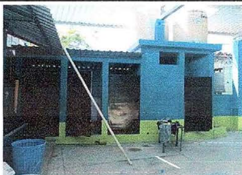
Foto No. 21, Módulo No. 4. Mantenimiento a estructura de puerta (lijado, cambio de tubo. Cepillado, sujeción, aplicación de pintura
