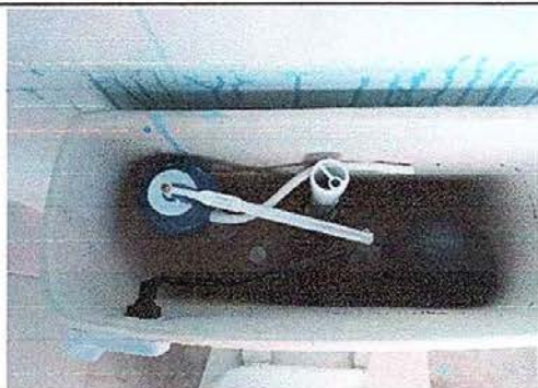
Foto No. 23, Módulo No. 4. Sustitución de accesorios de inodoro (contra llave, manguera de abasto y tanque.
