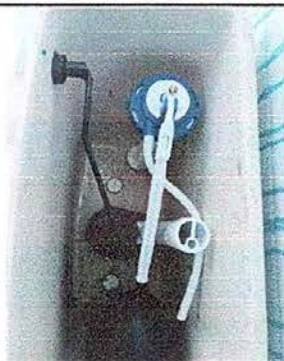
Foto No. 19, Módulo No. 4. Sustitución de accesorios de inodoro (contra llave, manguera de abasto y tanque).
