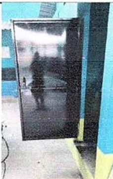
Foto No. 20, Módulo No. 4. Mantenimiento a estructura de puerta (lijado, cambio de tubo. Cepillado, sujeción, aplicación de pintura
