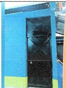
Foto No. 18, Módulo No. 3. Mantenimiento a estructura de puerta (lijado, cepillado, pintado)
