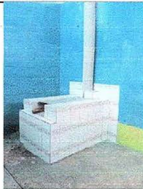
Foto No. 14, Módulo No. 3. Sustitución de plancha de metal de 3 hornillas e instalación de azulejo en estufa rural y sustitución de chimenea de concreto.
