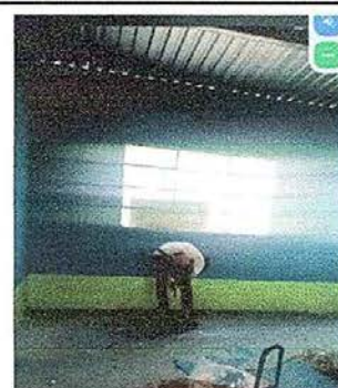
Foto No. 6, Módulo No. 1. Mantenimiento a estructura de puerta (lijado, cambio de tubo. Cepillado, sujeción, aplicación de pintura
