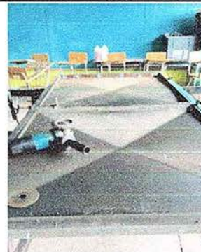
Foto No. 20, Módulo No. 4. Mantenimiento a estructura de puerta (lijado, cambio de tubo. Cepillado, sujeción, aplicación de pintura
