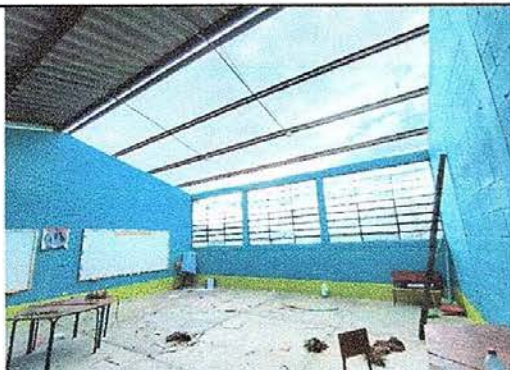
Foto No.9, Módulo No. 2. Sustitución de lámina, por lámina troquelada
