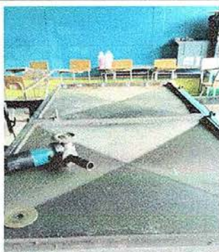
Foto No. 3, Módulo No. 1. Mantenimiento a estructura de puerta (lijado, cepillado)
