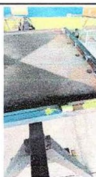
Foto No. 18, Módulo No. 3. Mantenimiento a estructura de puerta (lijado, cepillado, pintado)
