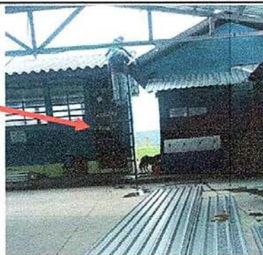
Foto No. 10, Módulo No. 2. Mantenimiento a estructura de puerta (lijado, cambio de tubo) Cepillado, sujeción, aplicación de pintura
