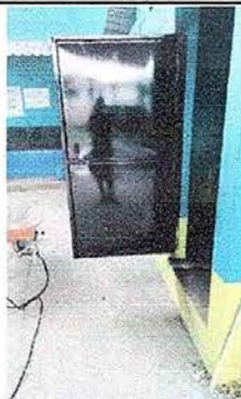
Foto No. 21, Módulo No. 4. Mantenimiento a estructura de puerta (lijado, cambio de tubo. Cepillado, sujeción, aplicación de pintura
