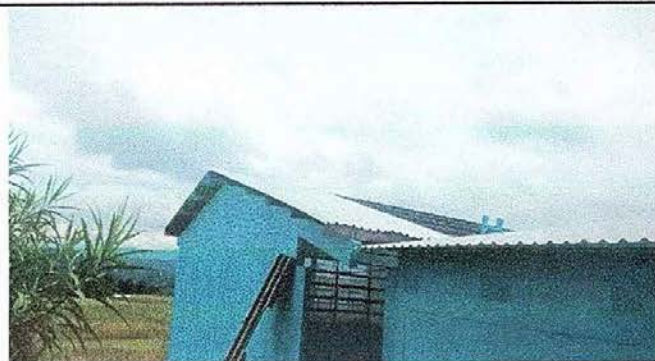
Foto No. 7, Módulo No. 2. Sustitución de lámina, por lámina troquelada aluzinc calibre 26, desinstalación de lámina.
