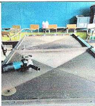
Foto No. 11, Módulo No. 2. Mantenimiento a estructura de puerta (lijado, cambio de tubo) Cepillado, sujeción, aplicación de pintura
