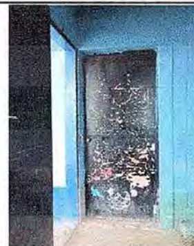
Foto No. 6, Módulo No. 1. Mantenimiento a estructura de puerta (lijado, cambio de tubo. Cepillado, sujeción, aplicación de pintura
