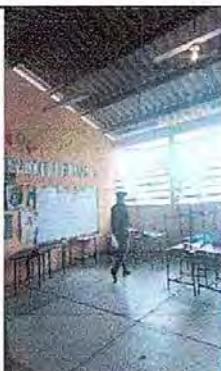
Foto No.9, Módulo No. 2. Sustición de lámina, por lámina troquelada
