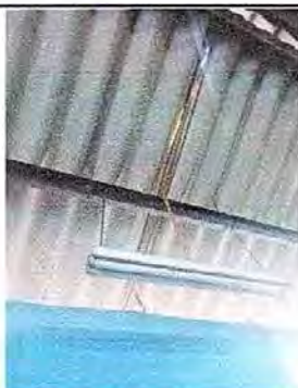
Foto No. 17, Módulo No. 3, sustitución de lámina por lámina troquelada aluzinc calibre 26, desinstalación de lámina. Sustitución de elementos de fijación (tornillos), sustitución de capotes de lámina para lámina
