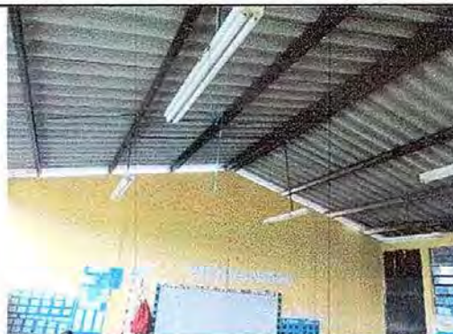
Foto No. 8, Módulo No. 2. Reparación de cableado eléctrico, sustitución de focos ahorradores.
