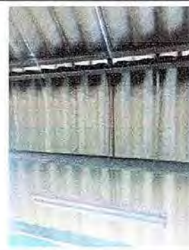
Foto No. 16, Módulo No. 3. Sustitución de focos ahorradores, sustitución de plafoneras, sustitución de interruptores, sustitución de ducto eléctrico más accesorios, sustitución de tomacorrientes.
