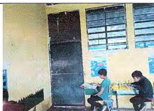
Foto No. 11, Módulo No. 2. Mantenimiento a estructura de puerta (lijado, cambio de tubo) Cepillado, sujeción, aplicación de pintura
