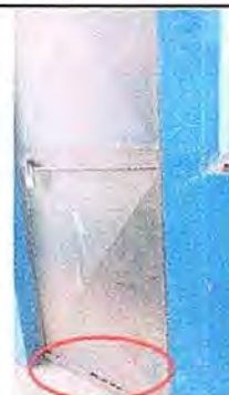
Foto No. 18, Módulo No. 3. Mantenimiento a estructura de puerta (lijado, cepillado, pintado)
