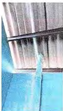
Foto No. 13, Módulo No. 3. Sustitución de chimenea de concreto y sustitución de lámina por lámina troquelada aluzinc calibre 26, desinstalación de lámina.
