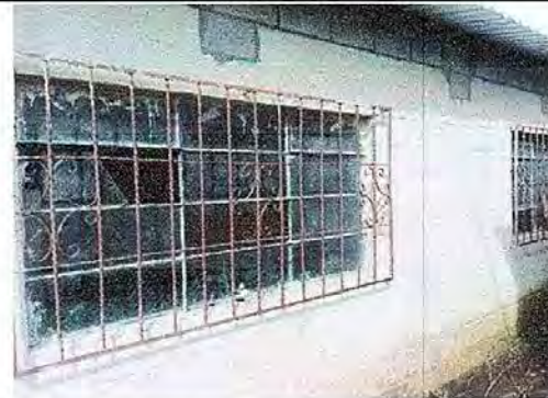
Foto No. 4, Módulo No. 1. Sustitución de vidrios
