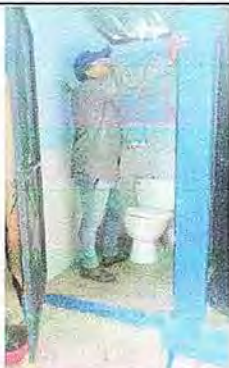
Foto No. 19, Módulo No. 4. Sustitución de accesorios de inodoro (contra llave, manguera de abasto y tanque.
