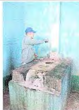
Foto No.14, Módulo No. 3. Sustitución de plancha de metal de 3 hornillas e instalación de azulejo en estufa rural y sustitución de chimenea de concreto.
