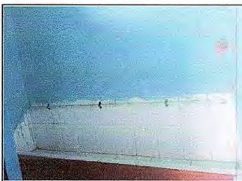
Foto 24, Módulo No. 4. Sustitución de llave para mingitorio.
