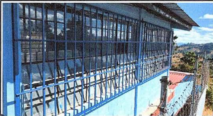
Foto 1: INSTALACION DE BALCONES
