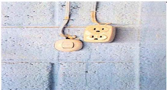
Foto 3: MÓDULO 4 SUSTITUCION DE TOMACORRIENTES
