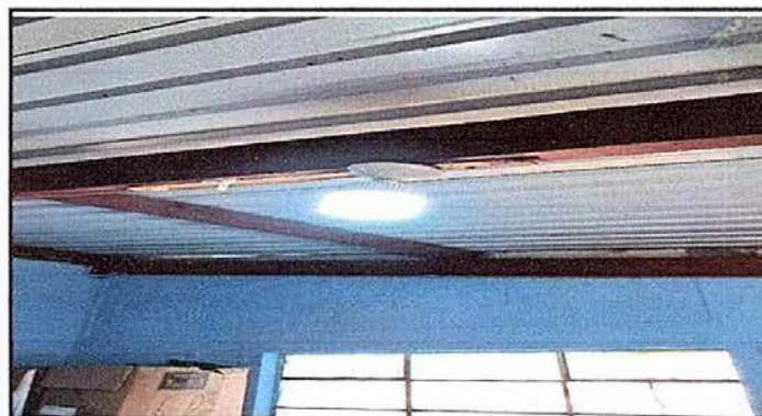
Foto 4: MÓDULO 4 SUSTITUCION DE FOCOS AHORRADORES
