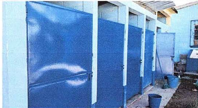
Foto 2: MÓDULO 1 MANTENIMIENTO DE PUERTAS
