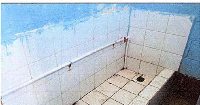
Foto 5: MÓDULO 1 SUSTITUCION DE TUBO DE MIGITORIO Y LLAVE E PASO
