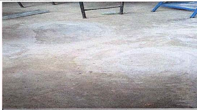
Foto 2: MÓDULO 4 REPARACION DE PISO TORTA DE CEMENTO
