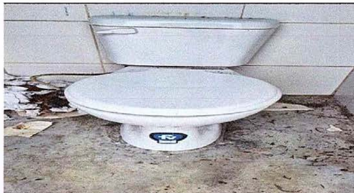
Foto 4: MÓDULO 1 SUSTITUCION DE SANITARIOS
