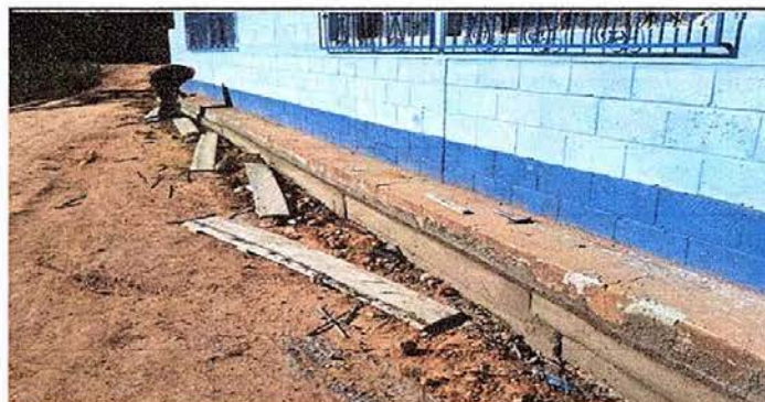
Foto 6: MÓDULO 4 MANTENIMIENTO DE BANQUETA DE CEMENTO
