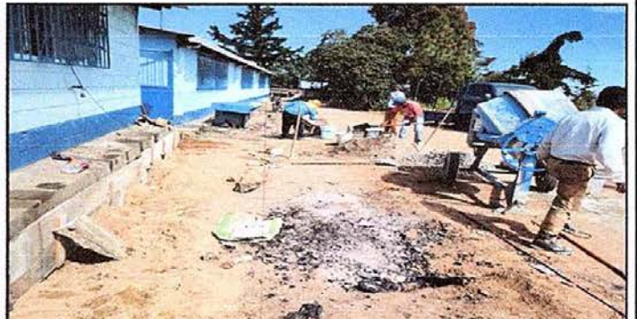
Foto 6: MÓDULO 4 MANTENIMIENTO DE BANQUETA DE CEMENTO
