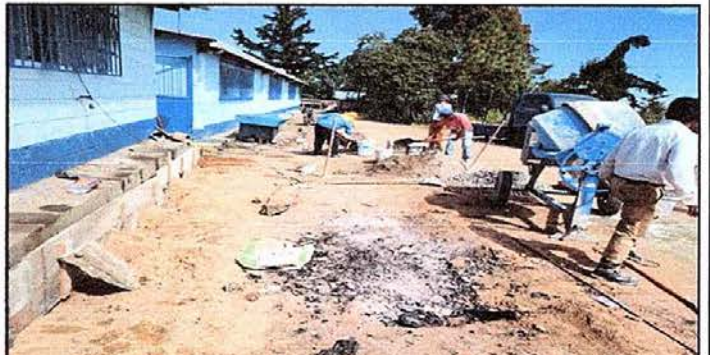
Foto 6: MÓDULO 4 MANTENIMIENTO DE BANQUETA DE CEMENTO
