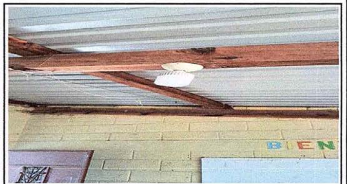
Foto 4: MÓDULO 4 SUSTITUCION DE FOCOS AHORRADORES
