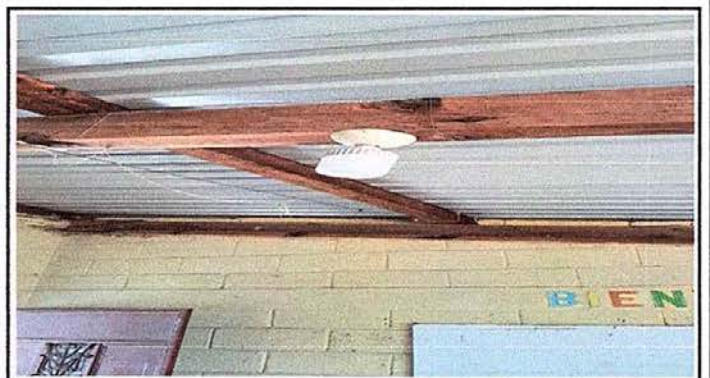
Foto 4: MÓDULO 4 SUSTITUCION DE FOCOS AHORRADORES
