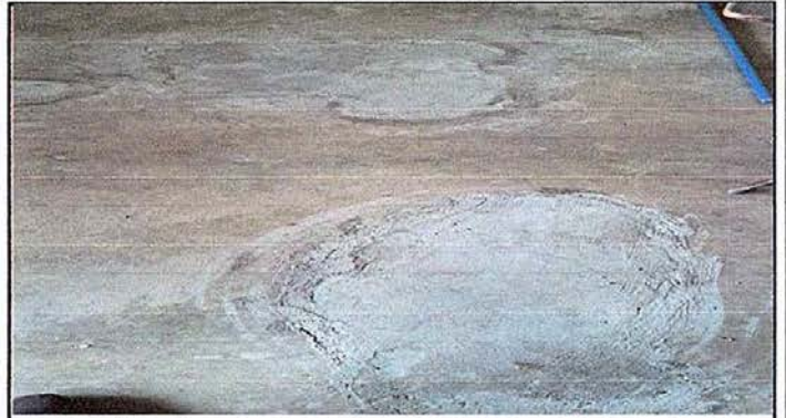
Foto 2: MÓDULO 4 REPARACION DE PISO TORTA DE CEMENTO
