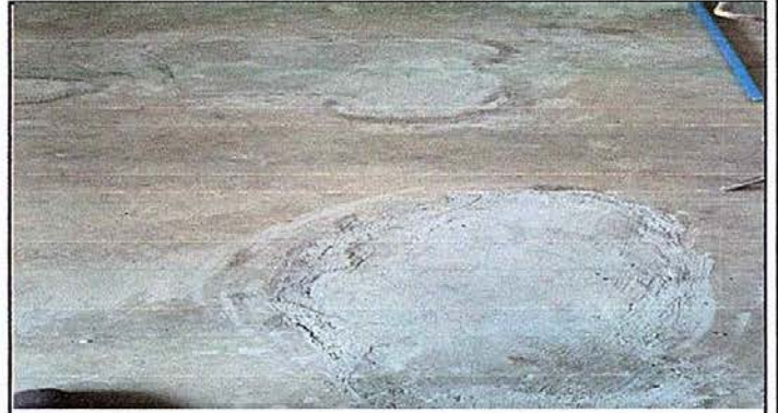
Foto 2: MÓDULO 4 REPARACION DE PISO TORTA DE CEMENTO
