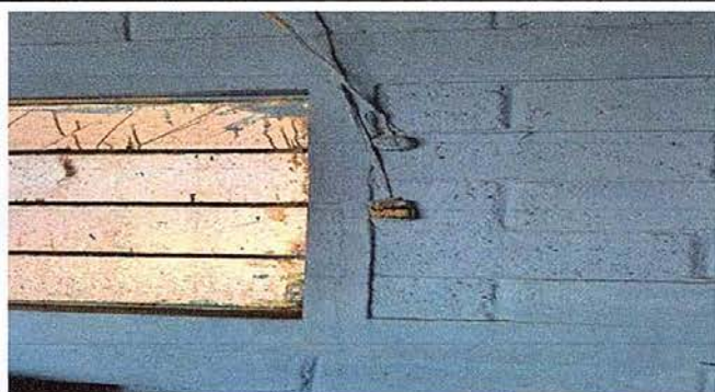
Foto 3: MÓDULO 4 SUSTITUCION DE TOMACORRIENTES
