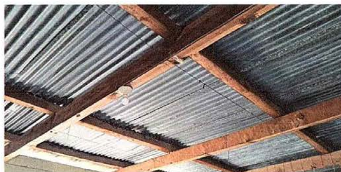
Foto 4: MÓDULO 4 SUSTITUCION DE FOCOS AHORRADORES
