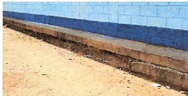
Foto 6: MÓDULO 4 MANTENIMIENTO DE BANQUETA DE CEMENTO
