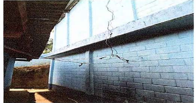
Foto 2: MÓDULO 5 REPACION DE CABLEADO ELECTRICO
