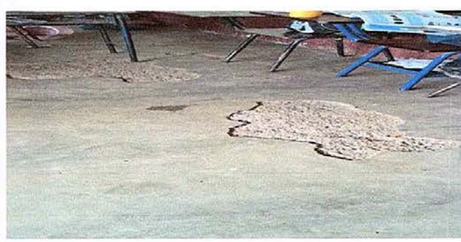
Foto 2: MÓDULO 4 REPARACION DE PISO TORTA DE CEMENTO
