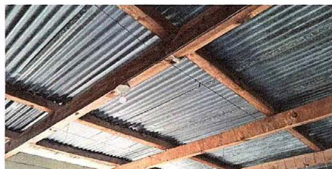
Foto 4: MÓDULO 4 SUSTITUCION DE FOCOS AHORRADORES
