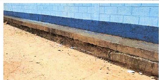
Foto 6: MÓDULO 4 MANTENIMIENTO DE BANQUETA DE CEMENTO
