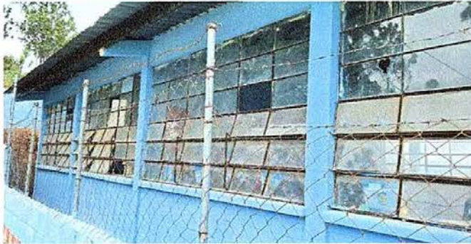
Foto 1: MÓDULO 5 REPARACIÓN DE MURO PERIMETRAL
