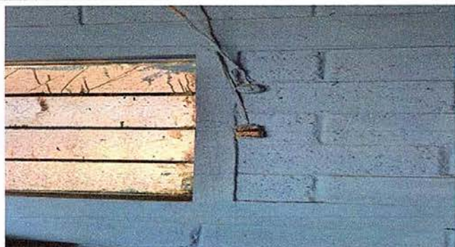
Foto 3: MÓDULO 4 SUSTITUCION DE TOMACORRIENTES
