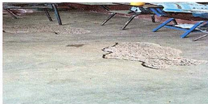
Foto 2: MÓDULO 4 REPARACION DE PISO TORTA DE CEMENTO
