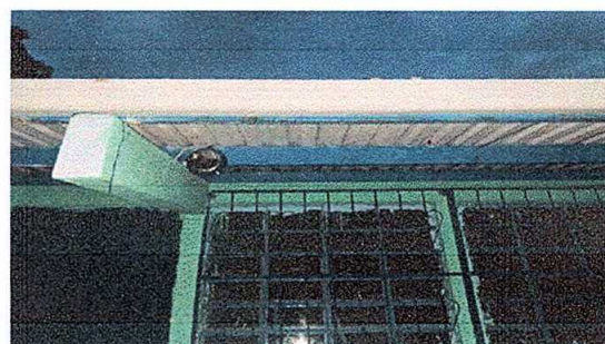
Foto 6: Modulo . Sustitución de canales de pvc
