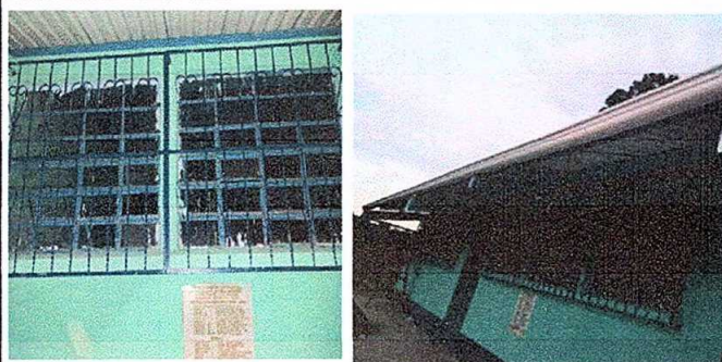
Foto1: Modulo 1. Sustitución a instalacón de balcones de hierro en ventana y sustitución de plafoneras
