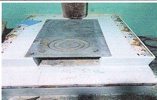
Foto 5: Modulo 5. Sustitución de plancha de metal de 3 ornillas
