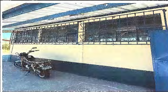
Foto 2. Modulo 1: Suminstro e instalación de balcon de hierro en ventana
