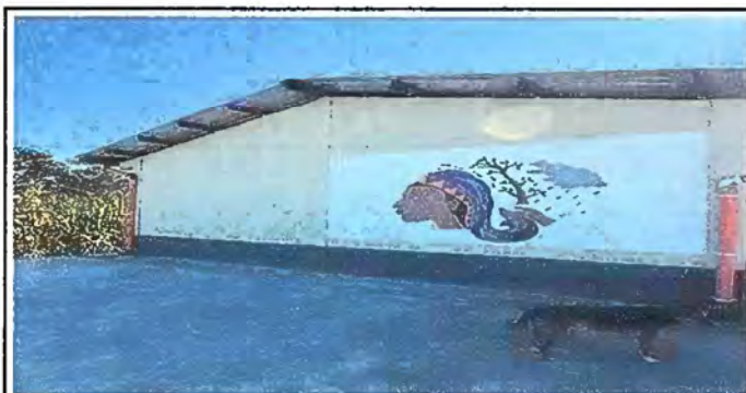
Modulo 2: Pintura en muros interior y exterior
