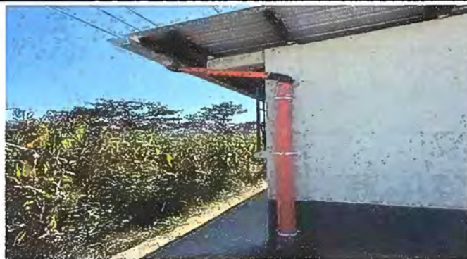
Foto 1. Modulo1: Sustrución de canales de PVC
